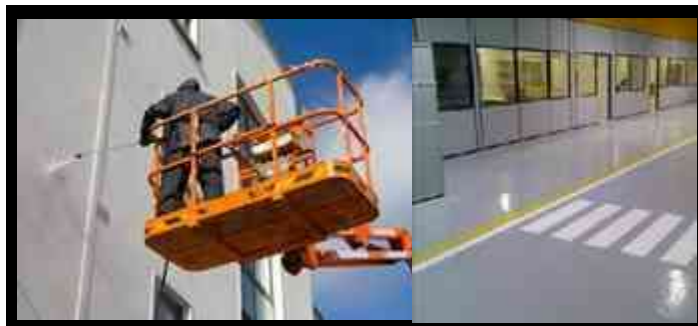
Ilustración 23 Aplicación de Pintura epóxica, Nervion® Pinturas http://nervion.com.mx/web/literatura/epoxicos.php [ltima vista 15/Octubre/2013]
