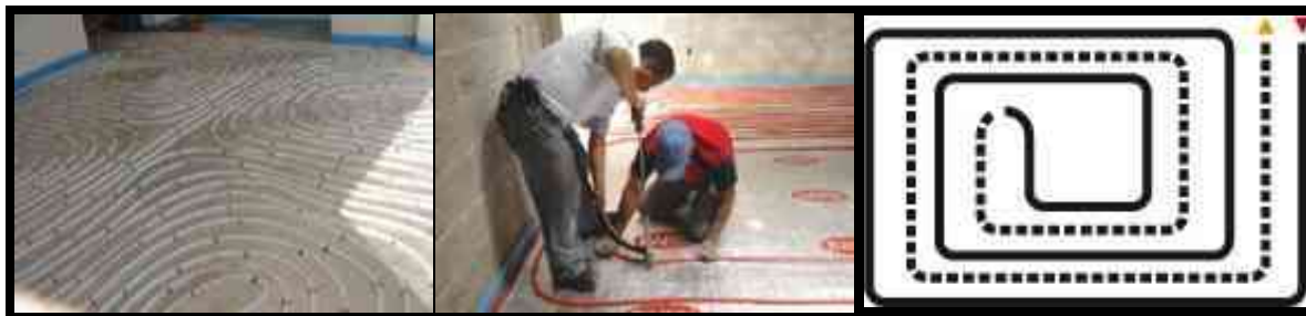
Ilustración 42 Suelo radiante http://www.funcosa.com.mx/productos/sistemas-climatizacion/calefaccion-suelo-radiante.html [última visita: 8/Septiembre/2014]
