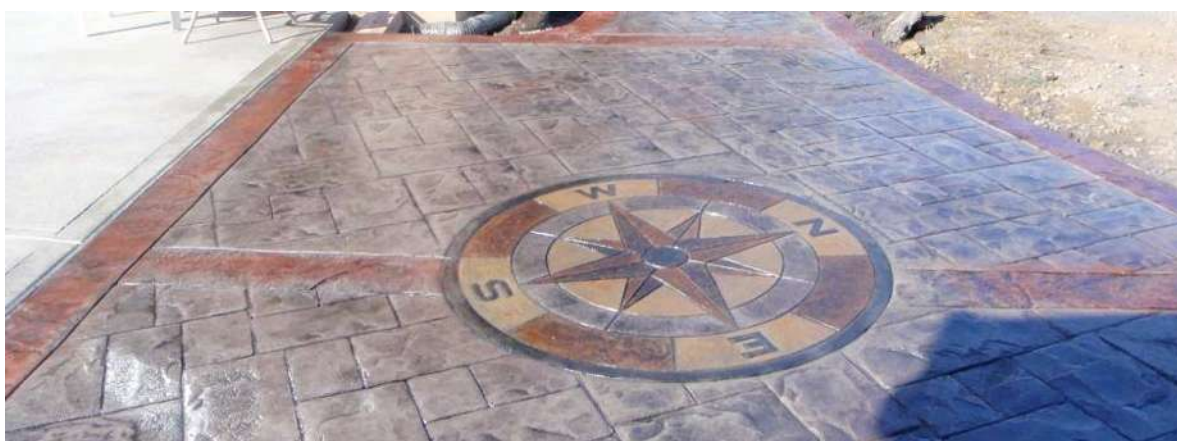
FOTO 38. CONCRETO ESTAMPADO [PLAZA]
