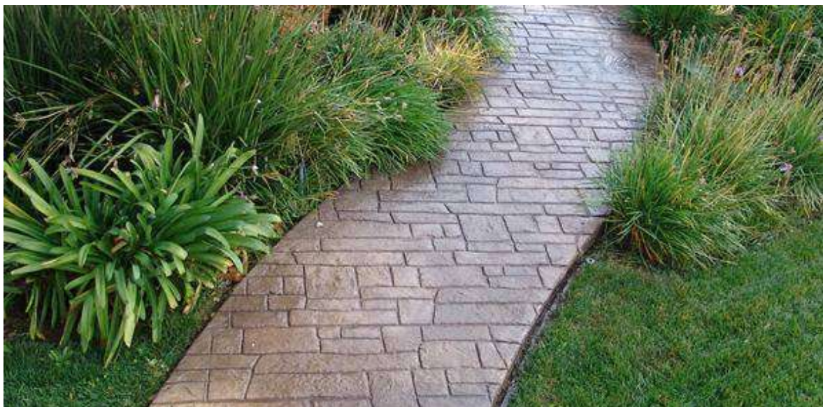
FOTO 37. CONCRETO ESTAMPADO [SENDERO]
