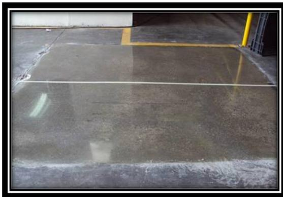
**Figura 78.** Concreto con terminado pulido
