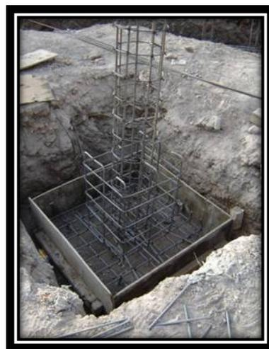
**Figura 67.** Zapata aislada en proceso de construcción.
