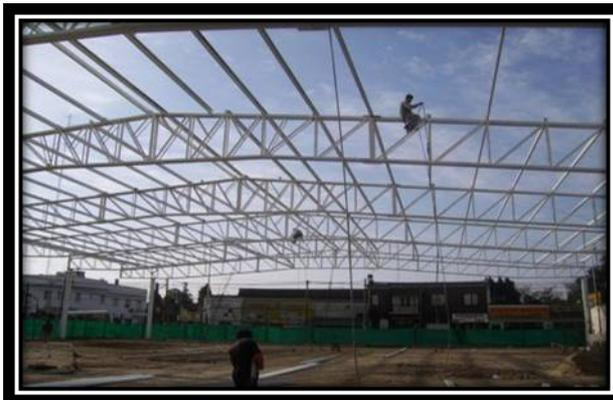
**Figura 74.** Estructuras metálicas soportando grandes claros
