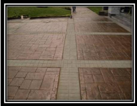
**Figura 80.** Concreto con terminación estampado
