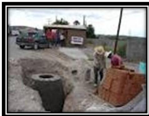
**Figura 59.** Construcción de sistema de drenaje y alcantarillado.
