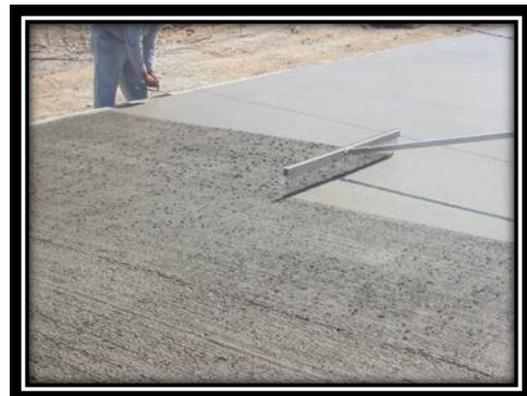
**Figura 79.** Concreto con terminado de textura rayado.
