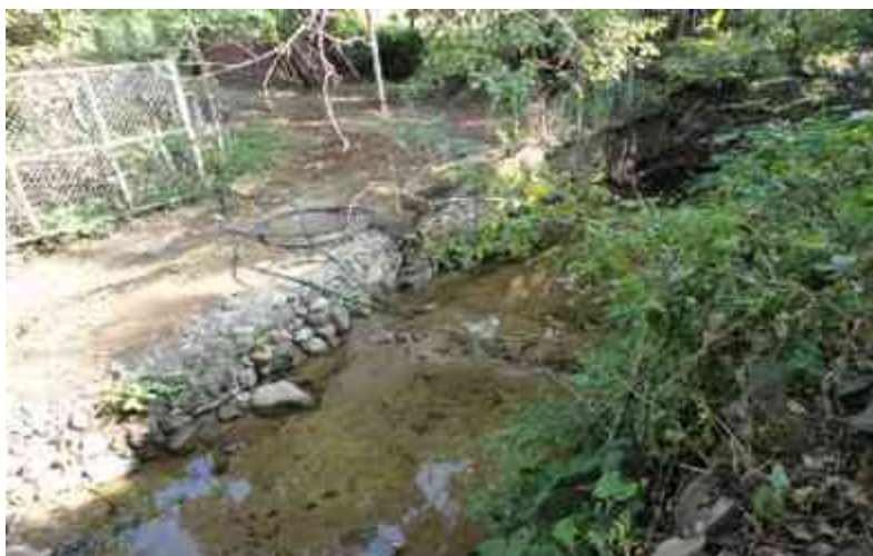
Foto 49 Casas en riesgo de inundación debido al arroyo que cruza la colonia.
