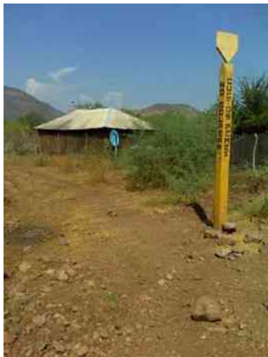
Foto 22, Postes que señalan donde pasa el ducto
