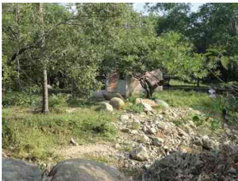
Foto 43 vivienda afectada por incremento del cauce del rio
