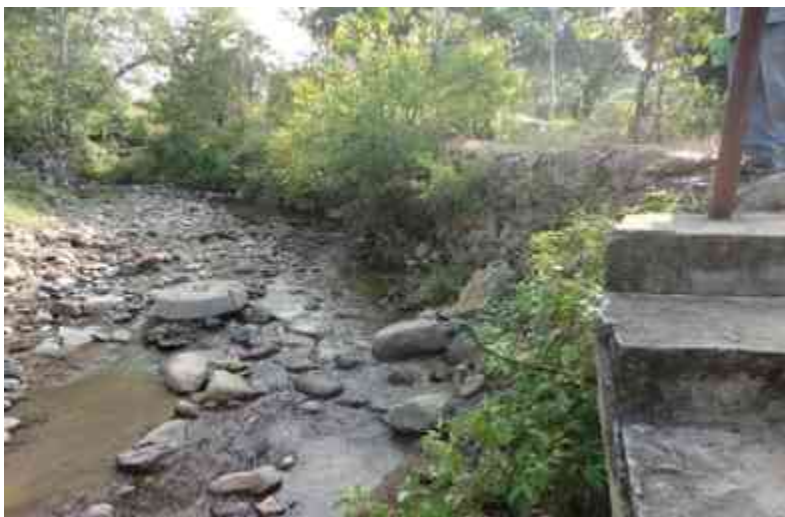
Foto 42 Colonias en riesgo de inundación debido a que cruza el rio Zapiro
