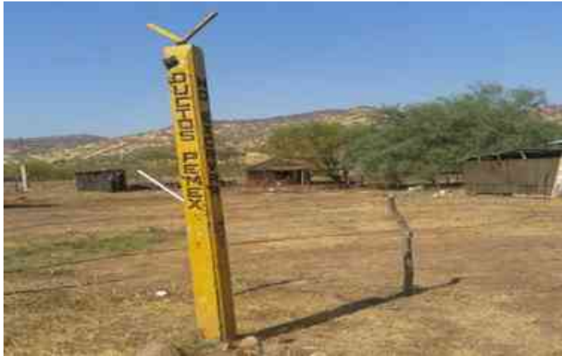
Foto 71 Señalización de Ductos de PEMEX
