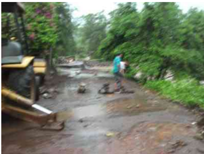
Foto 65 Limpieza de Zonas Federales y caminos del Rio Huamito
