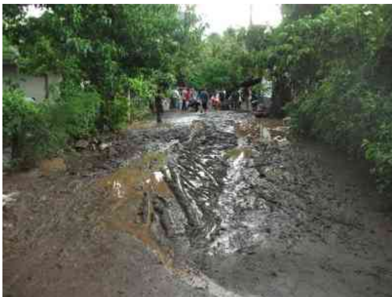
Foto 66 Limpieza de Caminos por afectación del desbordamiento del rio Huamito
