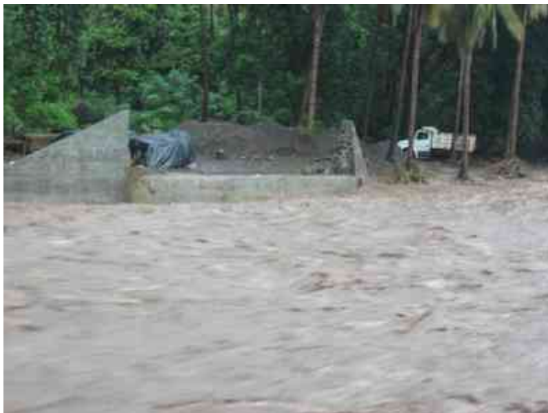
Foto 63 Afectación de Construcciones Resientes como puentes.
