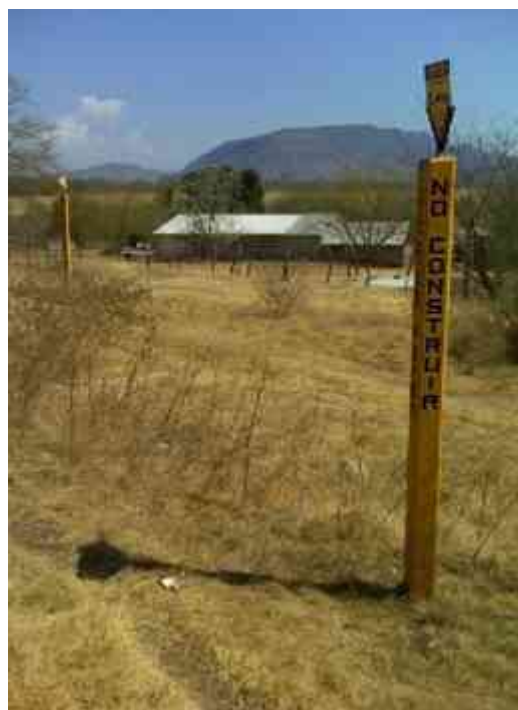
Foto 23, Vivienda asentada sobre el gasoducto de Petróleos de México.
