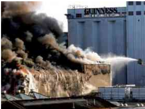
Fig.6 Imagen que muestra el incendio industrial como ejemplo de edificios con riesgo de incendio.
