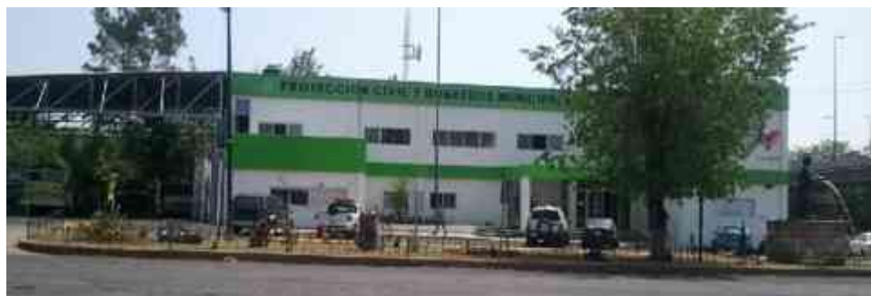
Fig.12 Fachada principal de la estación de bomberos de Morelia Michoacán.
