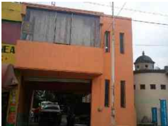
Fig.36 Fachada, estación de bomberos de La Piedad.
