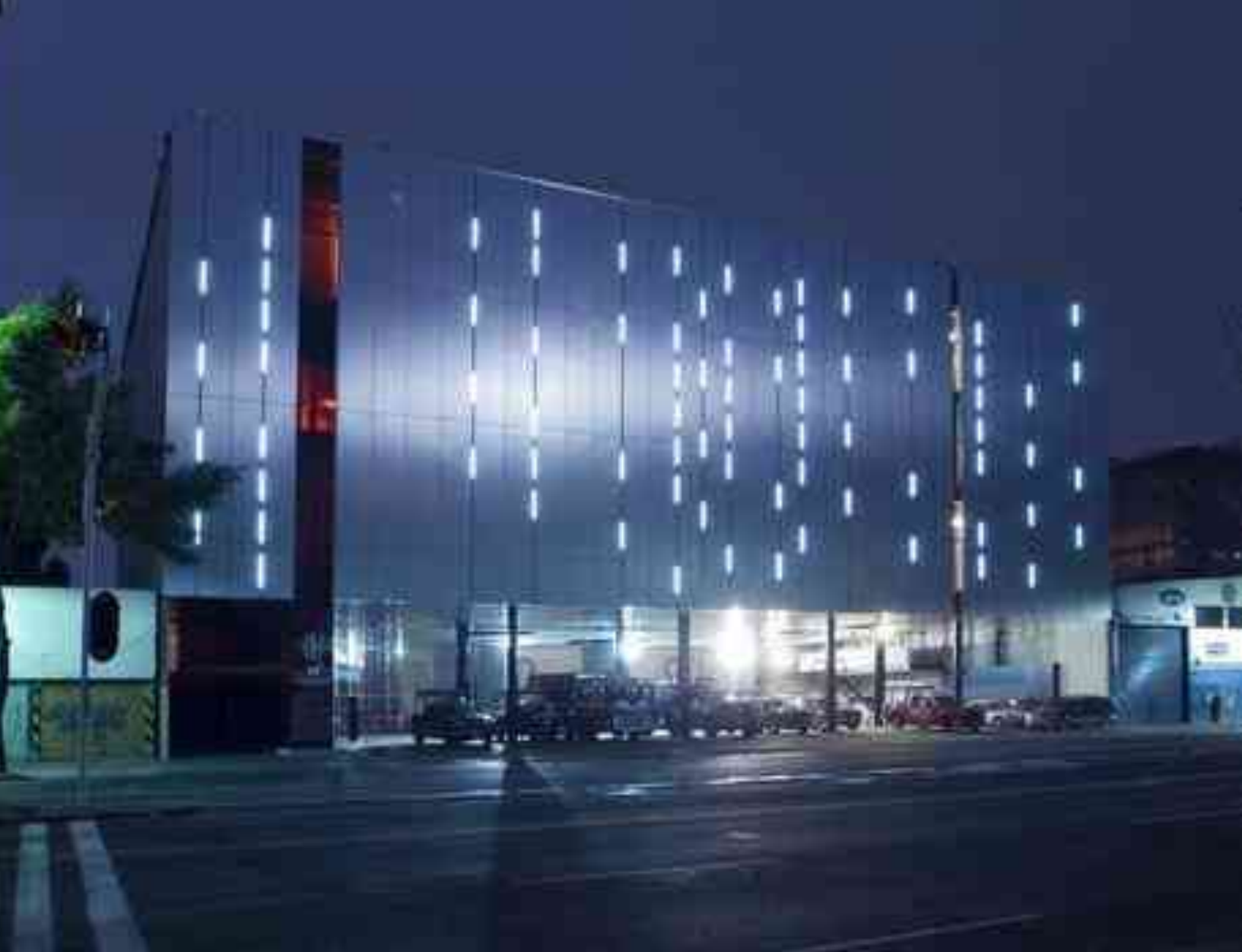
Fig.20 Estación de bomberos Ave Fénix, ciudad de México.
