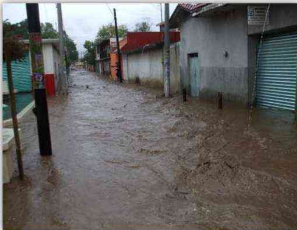
IMAGEN # 39. Inundación calle Morelos, Tuxpan Michoacán 2010.
