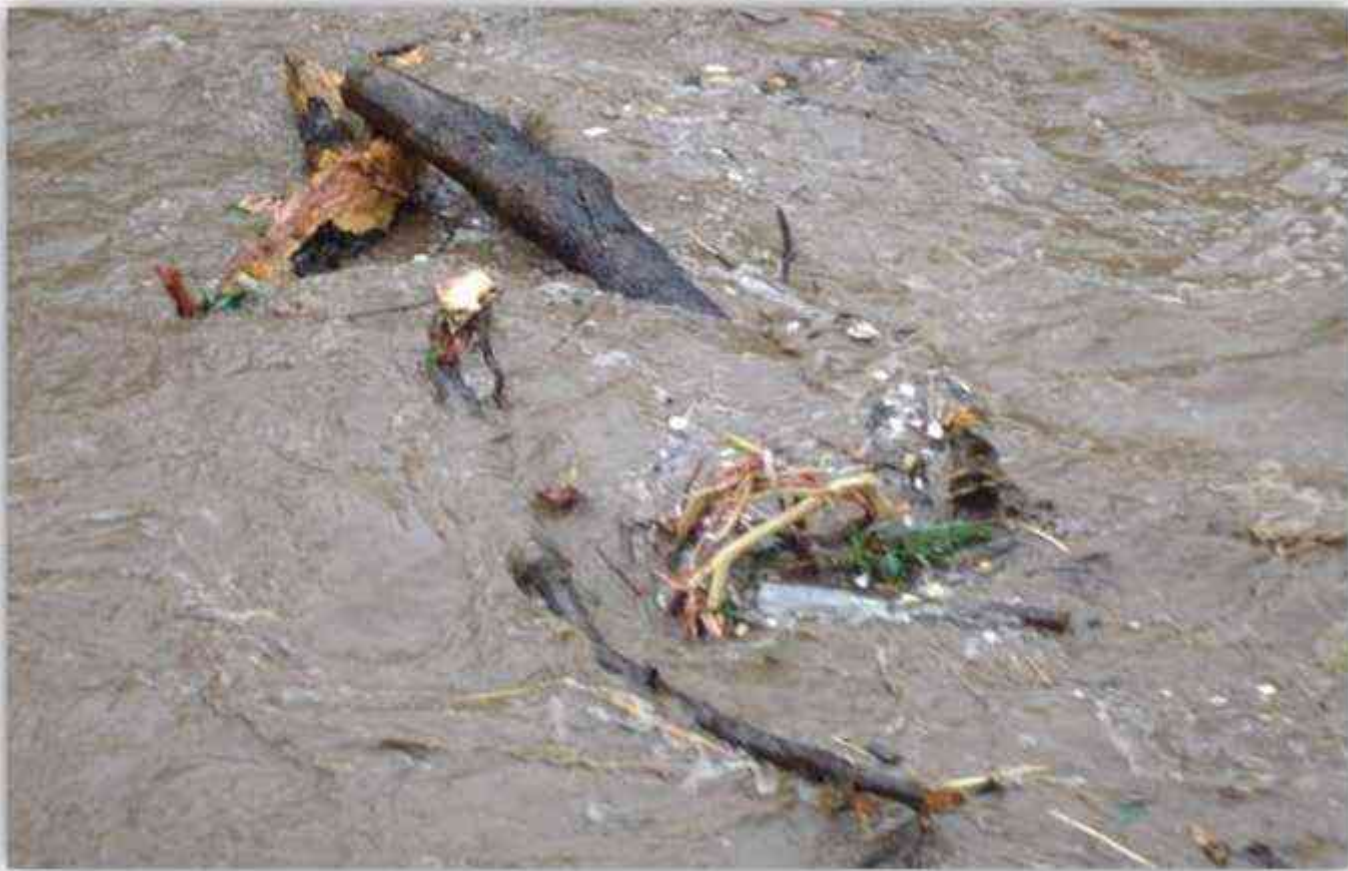
IMAGEN # 35. Azolve de coladera.
