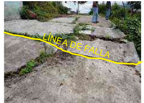
Riesgo Muy Alto Imagen # 4 y 5. Destrozos de la falla geológica en la col. Prolongación pueblita.
