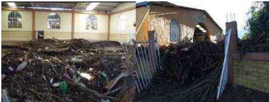
IMAGEN # 53 y # 54. Descuido de poner cerca o dentro del cauce el producto de la podas de árboles frutales. Y Nulo mantenimiento.
