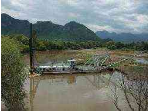
IMAGEN 85 y 86. Fotos de antes y después de la presa Tuxpan, (derivadora de Tuxpan)
