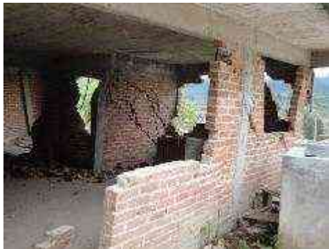
Riesgo Muy Alto Imagen # 4 y 5. Destrozos de la falla geológica en la col. Prolongación pueblita.
