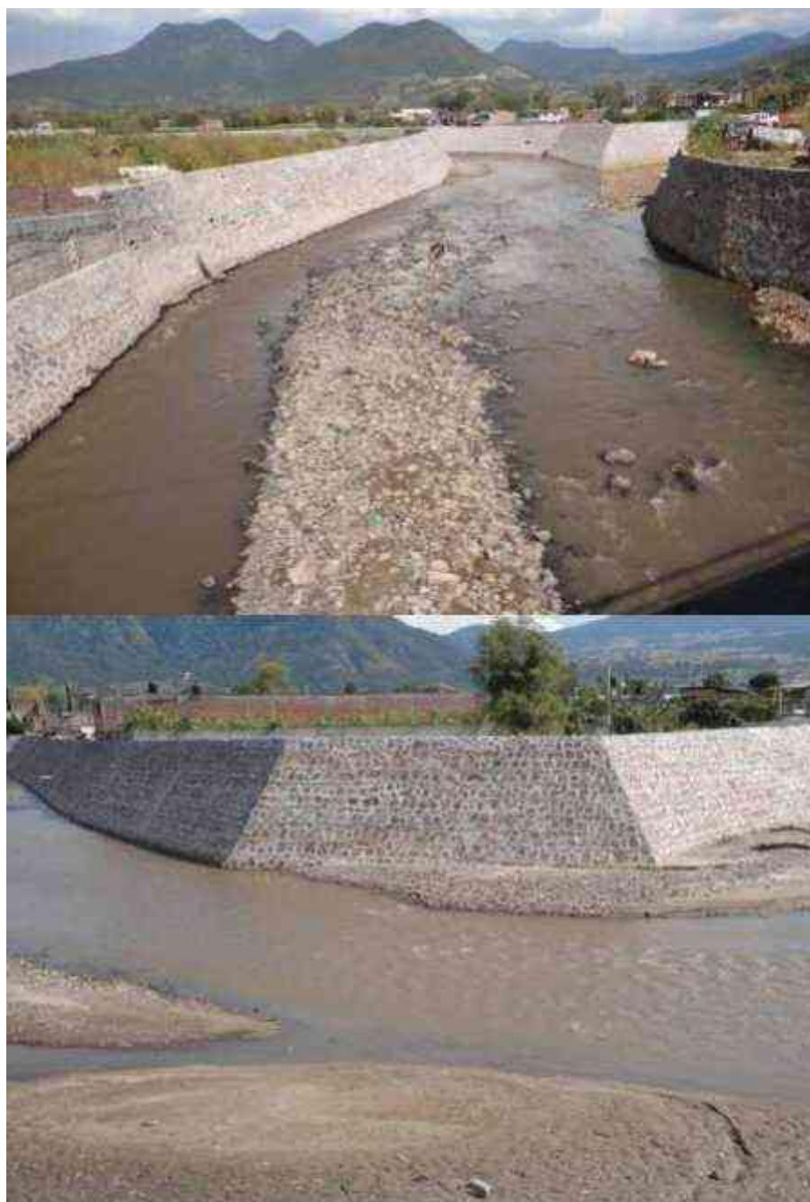
Imagen # 30 y 31. Ejemplos de soluciones al problema, con muro de contención en ríos de Tuxpan.
