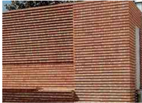
Ilustración 21. Muro de tabique rojo con acabado aparente.
