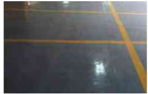
Ilustración 20. piso epóxico para transito vehicular.
