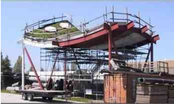
Estructura de la cubierta
