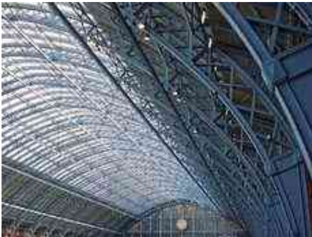
3.4.3 Cubierta de estructura de acero de nave ondulada
