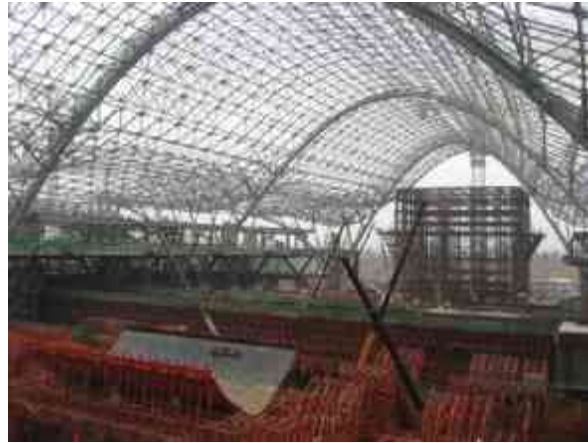
3.4.3 Cubierta de estructura de acero de nave ondulada
