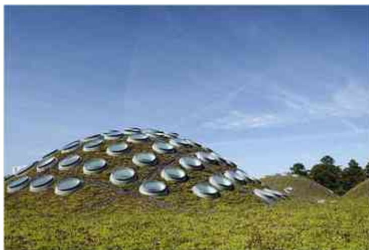
Imagen azotea de Academia de Ciencias de California
