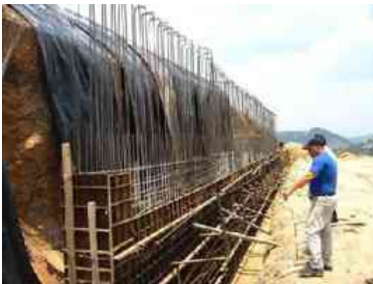
3.4.2 Armado de muro de concreto
