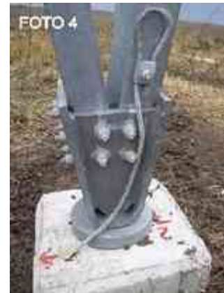
3.4.6 Montaje de estructura metálica a cimentación de concreto
