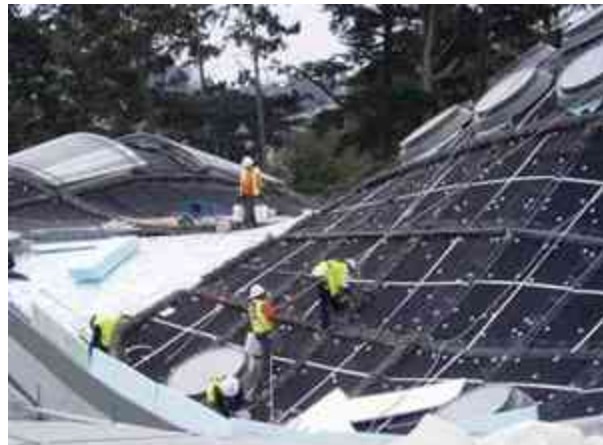
Impermeabilización de cubierta
