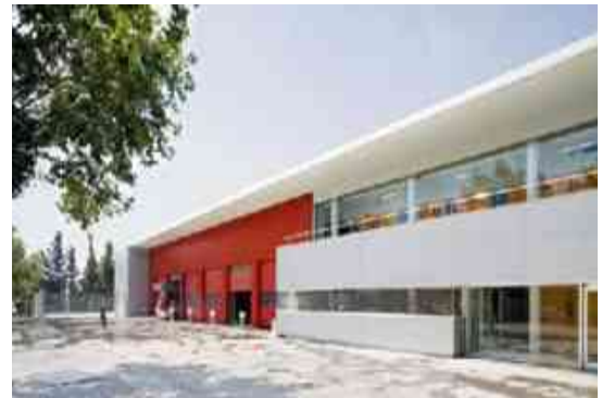
Ilustración 53 Vista Exterior Parque de Bomberos Mataró. Fuente: ( http://es.wikiarquitectura.com , 2011 b).
