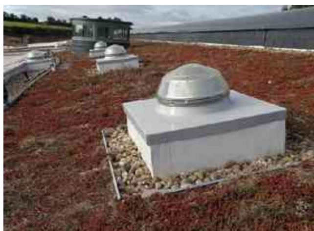
Imagen 49. También se puede montar sobre una base para que la sombra de cualquier elemento alrededor no interfiera con el sistema de Solatube (en este caso la vegetación de una azotea verde). Fuente: http://www.archithings.com/solatube-daylighting-system-meeting-the-green-roof-challenge/2009/10/21
