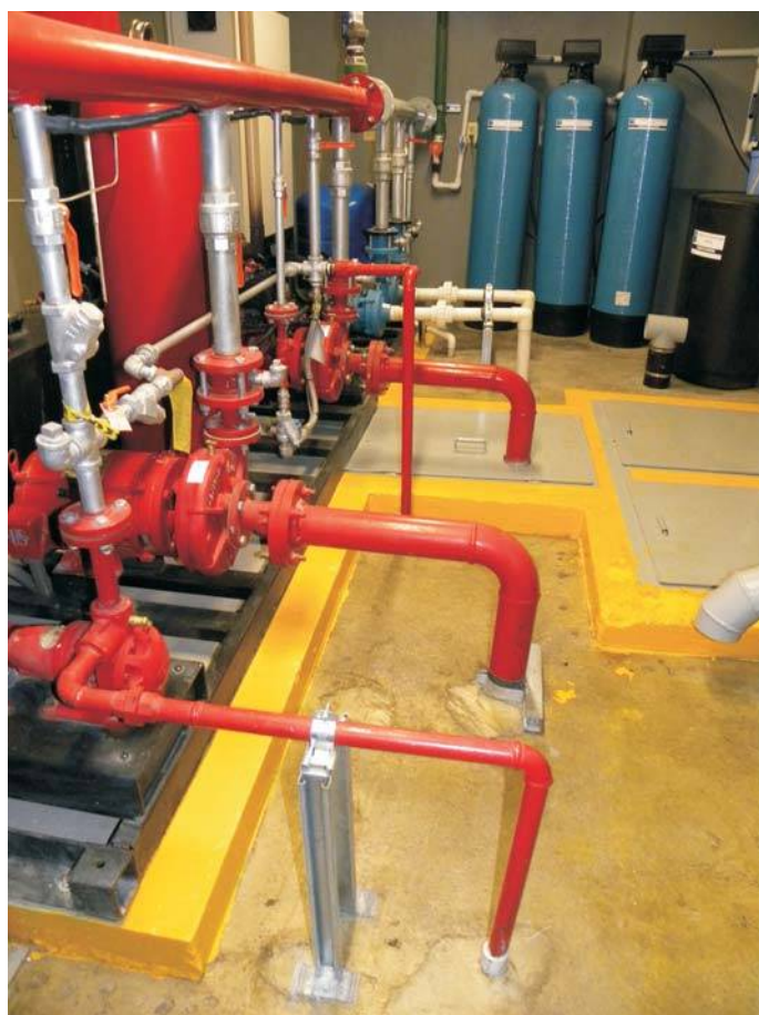
Cisterna y cuarto de bombas.
