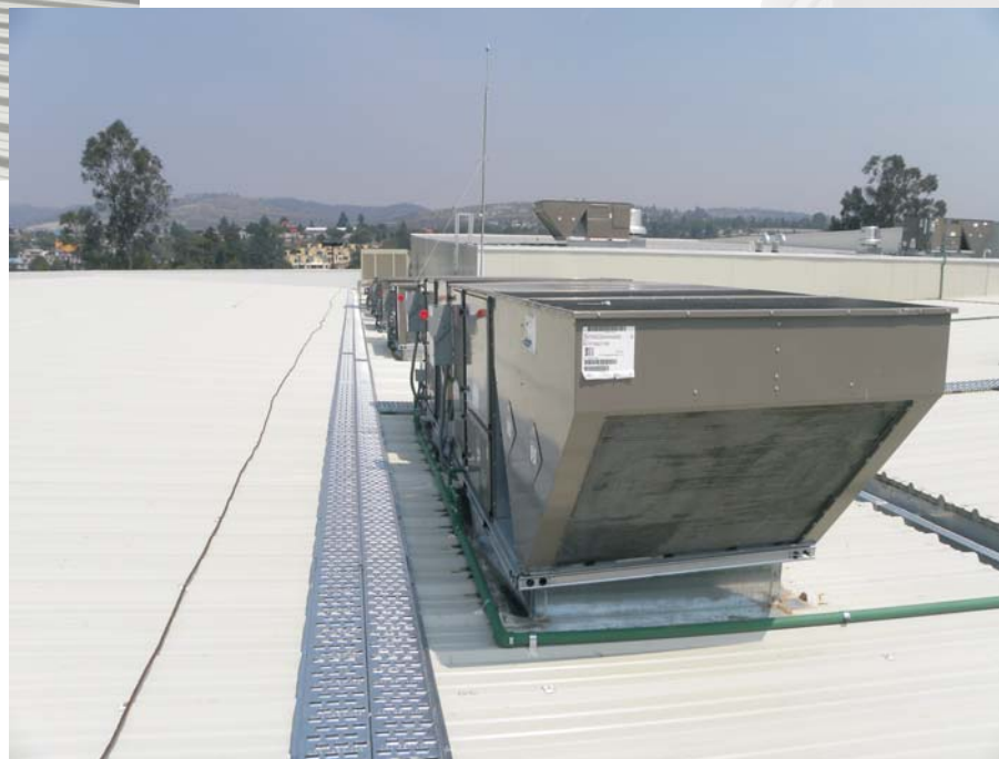
Cubierta, equipos de aire, pasos de gato.
