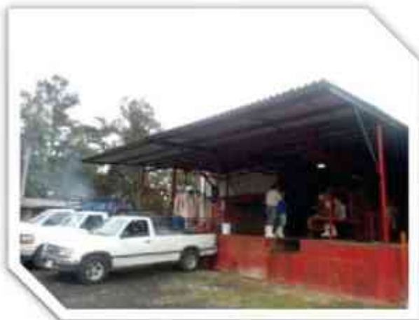
Imagen 98.- Andén de carga del producto, del Rastro Municipal de Uruapan, Michoacán. Foto: Jesús Galván
