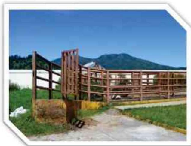
Imagen 109.- Andén de descarga del Rastro Municipal de Cheran, Michoacán. Foto: Jesús Galván Sierra
