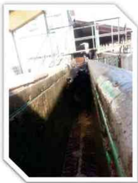
Imagen 50.- Área de ducto de traslado del Rastro Municipal de Morelia. Foto: Jesús Galván Sierra
