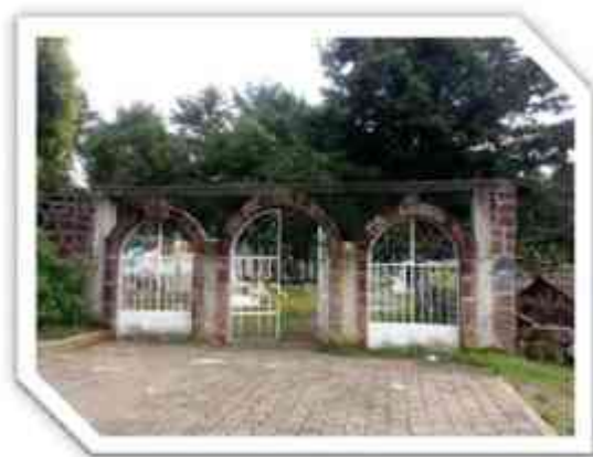
Imagen 27.- Fachada principal del campo santo en la comunidad de Charapan, Michoacán. Foto: Jesús Galván Sierra
