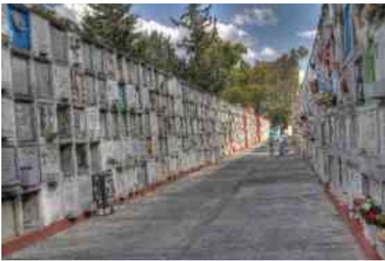
Imagen 69, Vista de las gavetas exteriores
