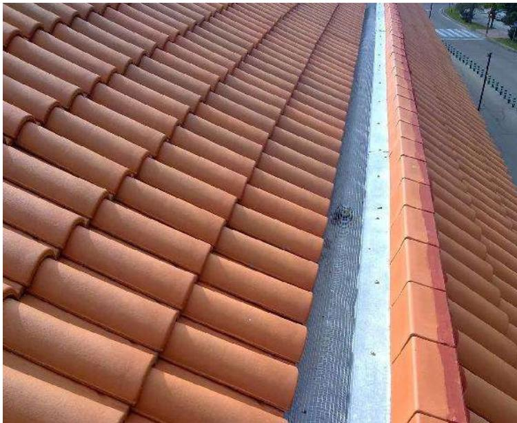
Figura 68: Elaboración del Autor. En esta fotografía se especifica el detalle para ocultar la canaleja y así evitar un exceso de escurrimiento por las lluvias.
