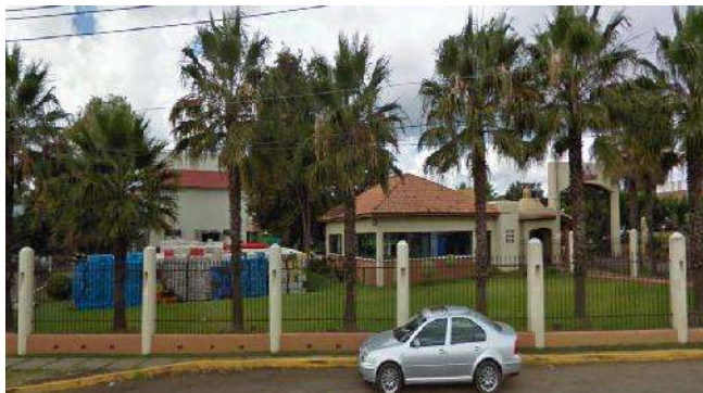
Imagen No.54: Fachada exterior
