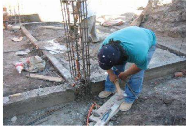
Imagen No.25: armado de castillo Fuente: http://www.termoplus.mx/muros.pdf
