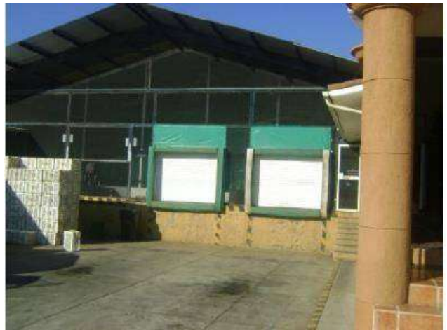
Imagen No.59: Zona de descarga del aguacate Fuente: https://www.google.com.mx/maps/place/Mission
