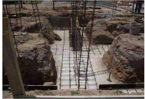
Imagen No.21: Armado de una zapata corrida Fuente: http://joseluismartinezhernandez.blogspot.mx/2011_03_01_archive.html
