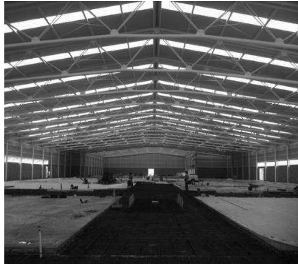
Imagen No.29: estructura metálica
