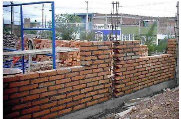
Imagen No.22: muro de tabique rojo Fuente: http://www.aguascalientes.gob.mx/transparencia/calidad/sop/obras/ReportesVarios/imag
