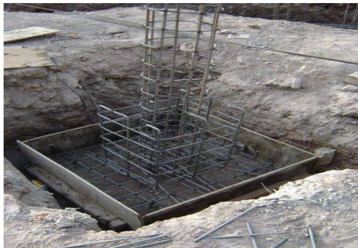
Imagen No.20 : Armado de una zapata aislada Fuente: http://joseluismartinezhernandez.blogspot.mx/2011_03_01_archive.html
