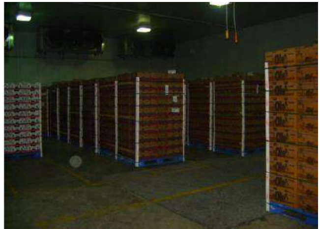
Imagen No.58: Cámaras de enfriamiento Fuente: https://www.google.com.mx/maps/place/Mission
