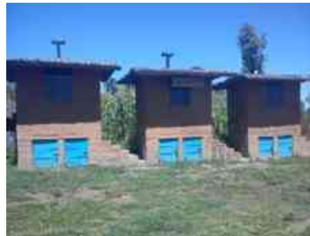
Ilustración 12 algunas construcciones sin orden en el terreno
