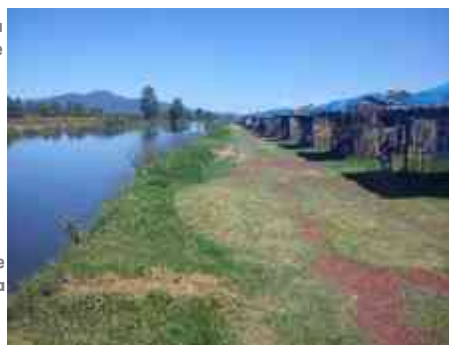
Ilustración 14 Canal para construcción de muelle sustentable
