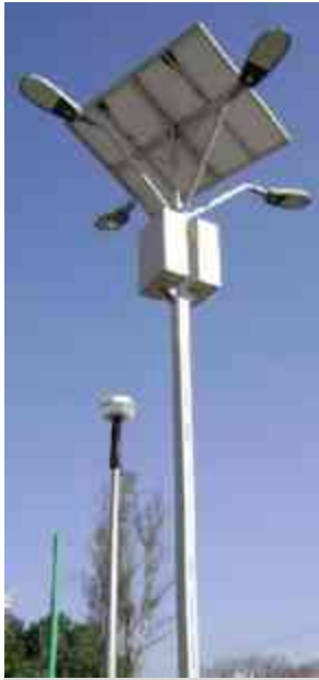
Ilustración 14 Ejemplo de Luminaria Led para estacionamiento, http://www.esco-tel.com/luminarias_solares_para_alumbrado_publico.html
