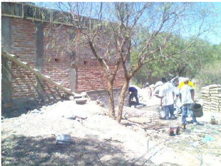
Foto 27 Realización de losa de concreto Autor. J. A Soria V.
