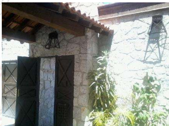
Foto 49 Fachada Interior vista de poniente a oriente, Autor J. A. Soria V.
