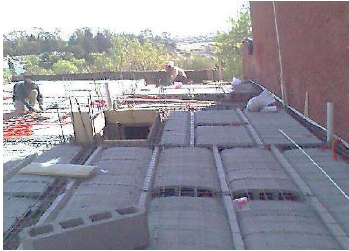
Foto 26 Colocación de vigueta y bovedilla Autor. J. A Soria V.
