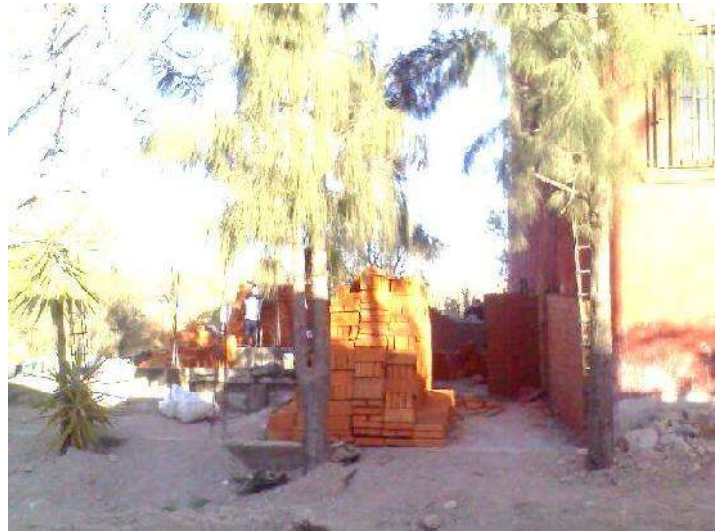
Foto 23 Relleno de tepetate y suministro de tabique Autor. J. A Soria V.
