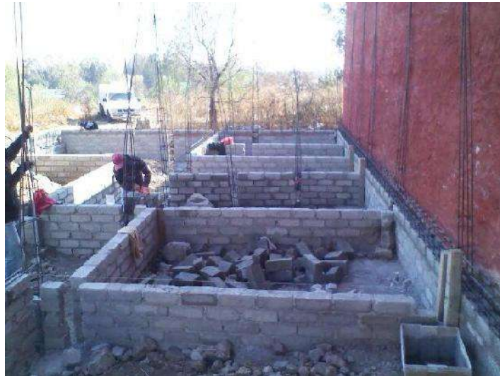
Foto 21 Muro de enrase con tabicón, castillos y cadena de desplante Autor. J. A Soria V.
