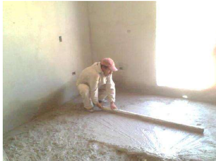
Foto 30 Realización de firmes Autor. J. A Soria V.
