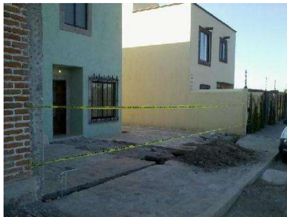
Foto 52 Estado original de barda Autor J. A. Soria V.
