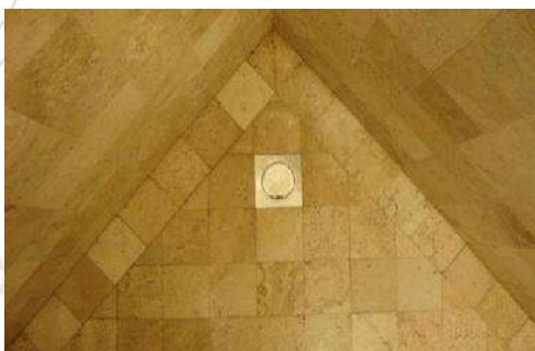
Foto 11 Detalle piso de baño; Autor. J. A Soria V.
