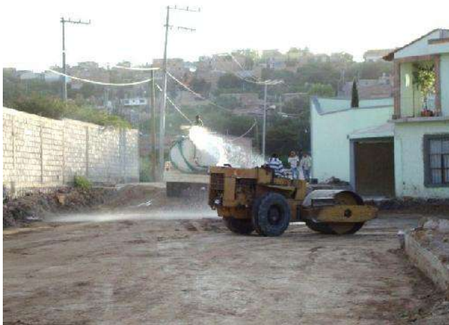
Ilustración 13 Vibro compactador realizando Compactación de material inerte en obra Pavimentación de calle prolongación de Baco, colonia San Martín, (25-sep.-2010) Autor. G. Rubí R.
