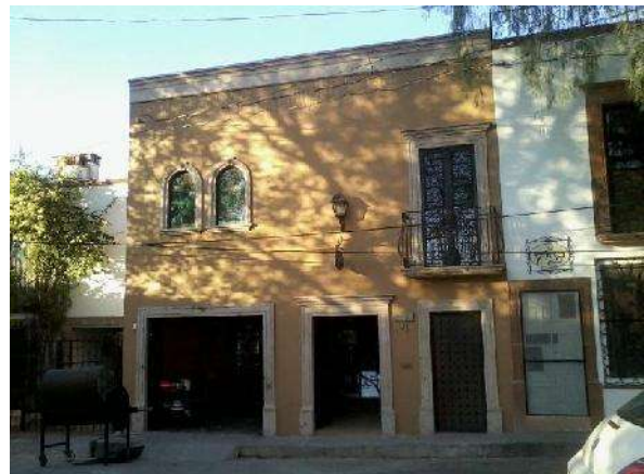
Foto 40 Fachada Terminada, Autor. J.A. Soria V.
