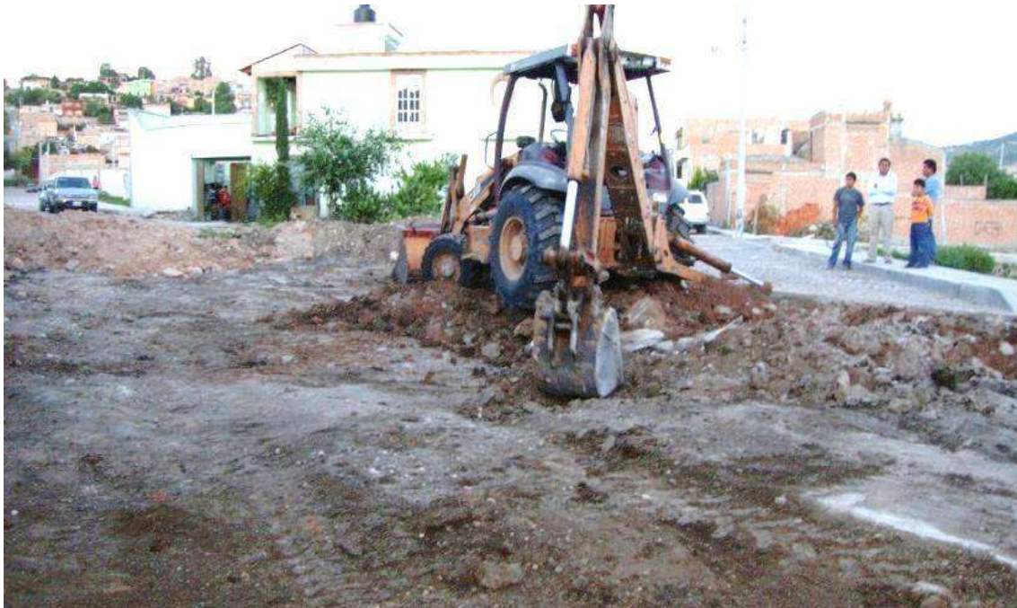
Ilustración 9 Retroexcavadora realizando Trabajos de cajeo y excavación, obra Pavimentación de calle prolongación de Baco, colonia San Martín, (14-ago-2010) Autor. G. Rubí R.
