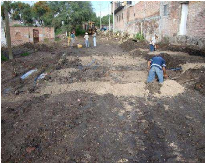
Ilustración 11 Excavación manual para Reposición de red de agua potable de obra Pavimentación de calle prolongación de Baco, colonia San Martín, (03-sep-2010) Autor. Autor. G. Rubí R.
