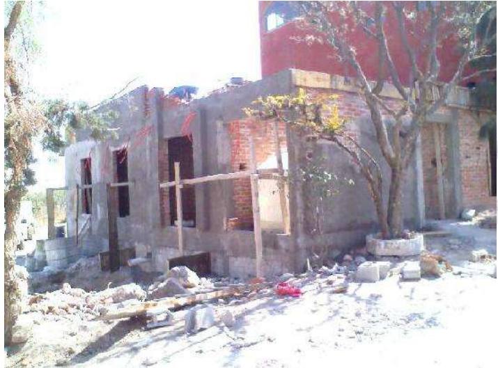
Foto 28 Instalaciones eléctricas, aplanados Autor. J. A Soria V.
