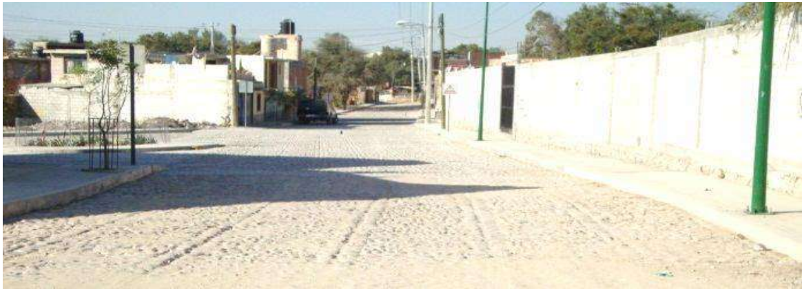
Ilustración 16 Vista general de obra terminada, Pavimentación de calle prolongación de Baco, colonia San Martín, (05-dic-2010) Autor. G. Rubí R.
