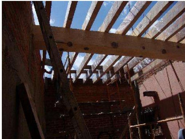
Foto 42 Estructura madera, Remodelación de la Casa Habitación- Construcción de departamento y local comercial la Calle potranca #4 fraccionamiento. Guadiana Autor. J.A. Soria V.
