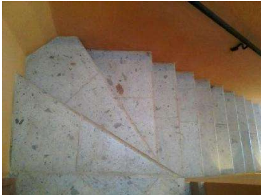
Foto 47 Escalera detalle peldaños de cantera, Autor. J.A. Soria V.
