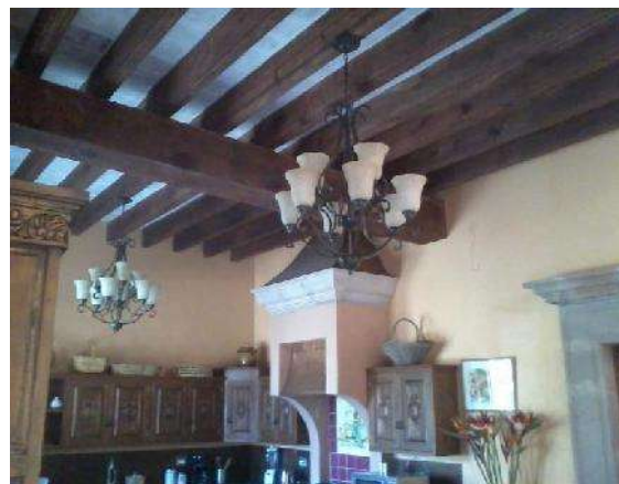
Foto 41 Cocina, Remodelación de la Casa Habitación- Construcción de departamento y local comercial la Calle potranca #4 fraccionamiento. Guadiana Autor. J.A. Soria V.
