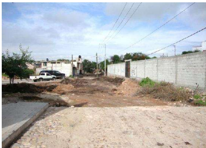
Ilustración 14 Vista general de obra en proceso, Pavimentación de calle prolongación de Baco, colonia San Martin, (04-sep-2010) Autor. G. Rubí R.
