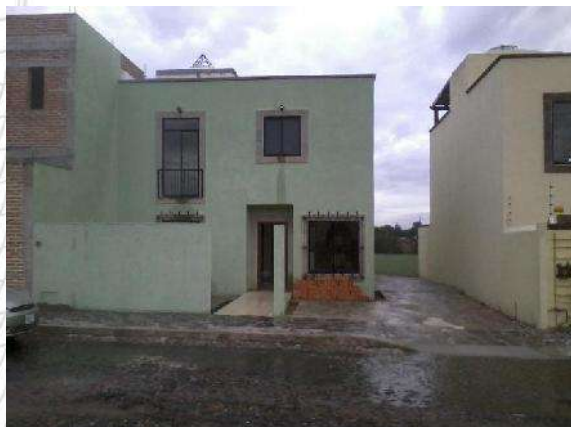
Foto 51 Estado original de barda Autor J. A. Soria V.
