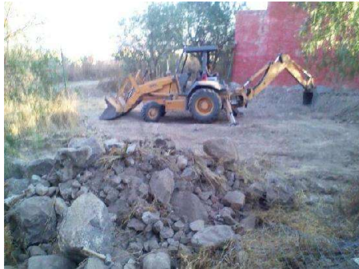
Foto 17 Despalme y excavación Autor. J. A Soria V.
