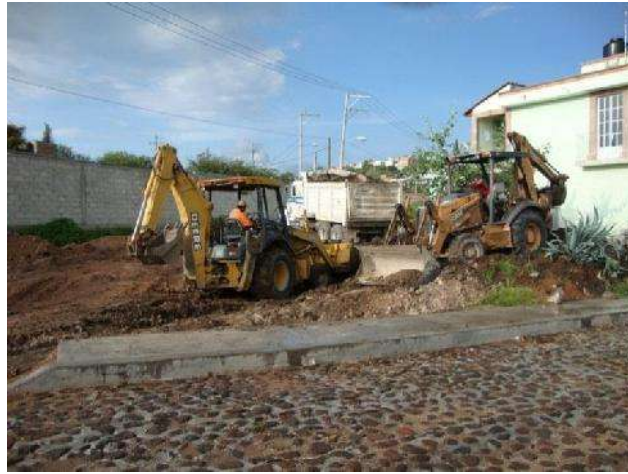
Ilustración 10 Dos retroexcavadoras Realizando Excavación, Carga y acarreo en la obra Pavimentación de calle prolongación de Baco, colonia San Martín, (25-ago-2010) Autor. G. Rubí R.
