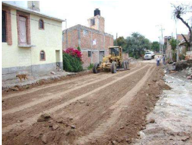
Ilustración 12 Moto conformadora realizando Tendido de material inerte en obra Pavimentación de calle prolongación de Baco, colonia San Martín, (21-sep-2010) Autor. G. Rubí R.
