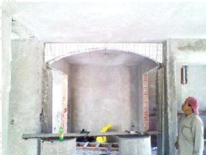
Foto 31 Forjado de arco entre sala y comedor Autor. J. A Soria V.
