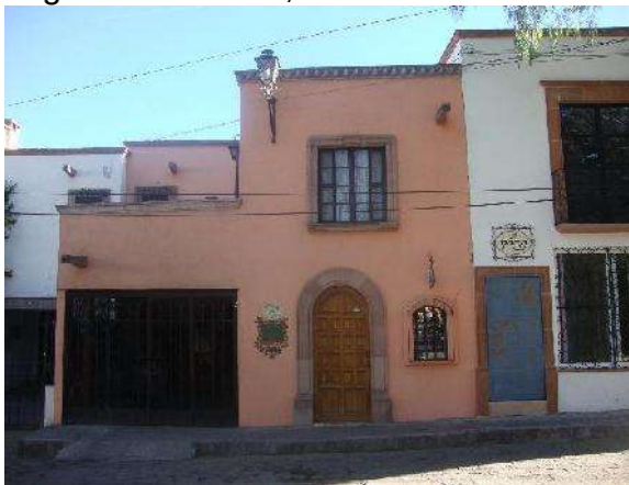
Foto 39 Fachada Estado original, Autor. J.A. Soria V.
