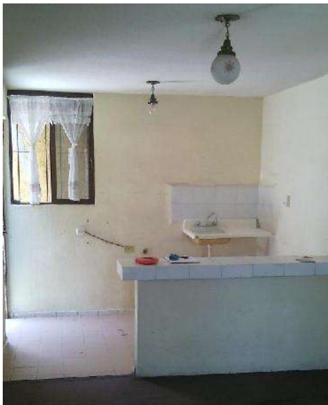
Foto 53 Vista interior cocina y barra estado original, Autor J. A. Soria V.
