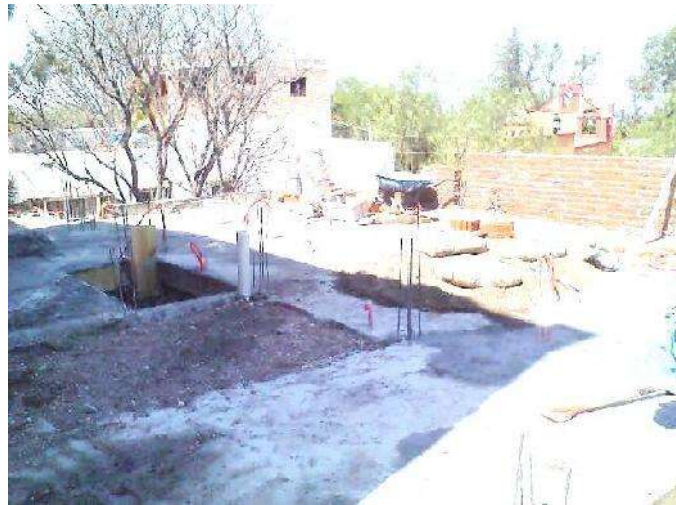
Foto 34 Azotea se observan las instalaciones preparadas para el segundo nivel Autor. J. A Soria V.
