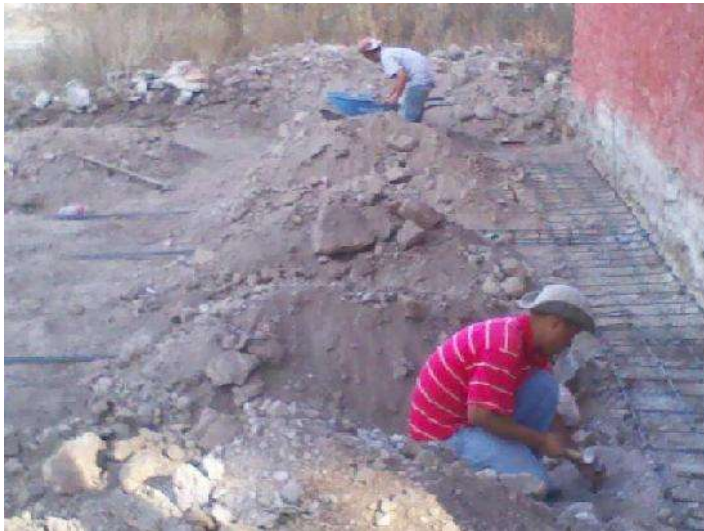
Foto 20 Habilitado y armado de acero en zapata corrida. Autor. J. A Soria V.
