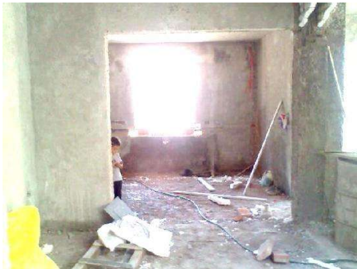
Foto 33 Vista de comedor y cocina al fondo ventana a la calle Autor. J. A Soria V.
