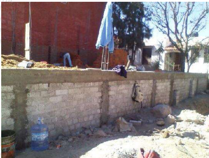
Foto 22 Muro de enrase castillos y relleno de tepetate Autor. J. A Soria V.
