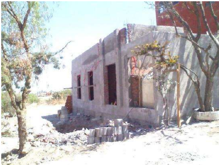
Foto 29 Aplanado de fachadas Autor. J. A Soria V.
