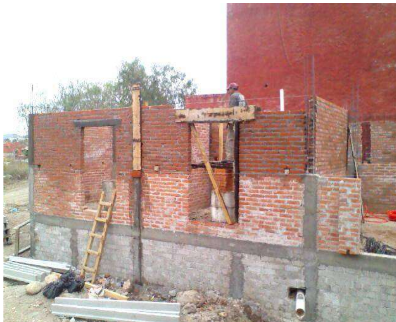
Foto 25 Muros de tabique y cerramientos Autor. J. A Soria V.
