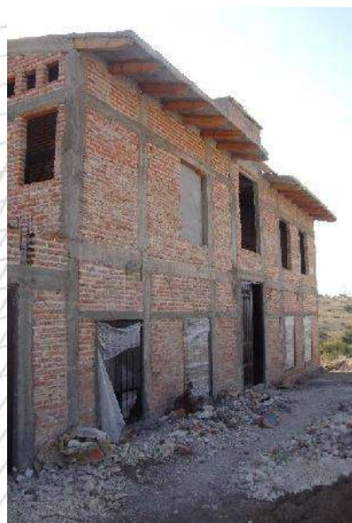
Foto 36 Proceso de obra fachada poniente, Autor. J.A. Soria V.
