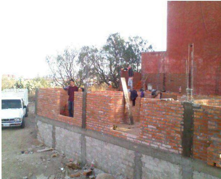
Foto 24 Muro de tabique de barro y castillos Autor. J. A Soria V.
