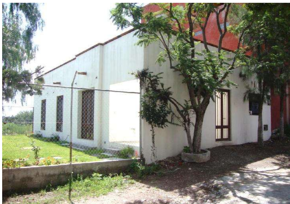
Foto 16 Vista del conjunto obra terminada Autor. J. A Soria V.
