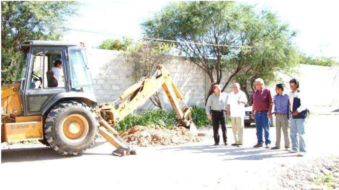
Ilustración 8 Retroexcavadora Inicio de obra Pavimentación de calle prolongación de Baco, colonia San Martin, (04-ago-2010) Autor. J.A. Soria V.
