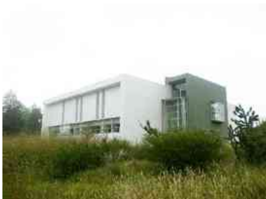
Imagen 42: Edificio de la Facultad de Biología, Fachada Norte
