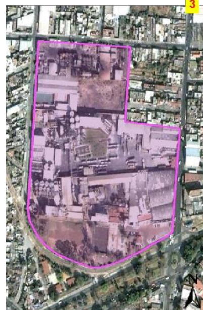
Fig 47 Imagen aérea del terreno ubicado en la zona industrial Santa Lucía de la ciudad de Morelia, Mich. AAE. Google Maps.
