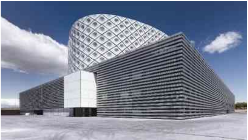
Imagen 19 Fachada Principal, Alfonso Quiroga, Fachada del proyecto principal., archdaily.com, 2012.
