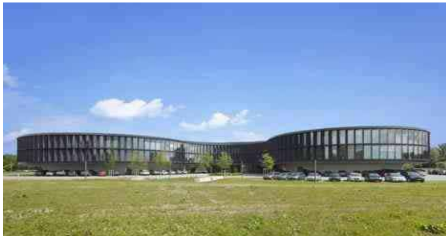
Imagen 61. Vista Exterior Frontal del Edificio
