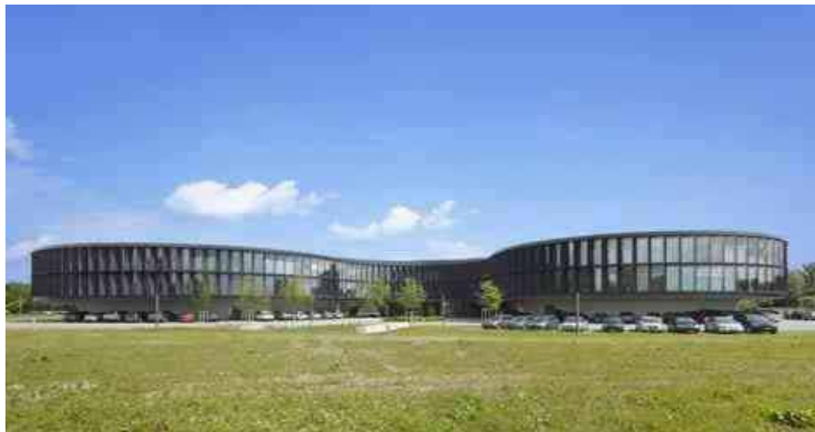
Imagen 61. Vista Exterior Frontal del Edificio
