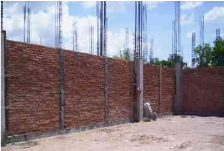
Fig.90. Muros de tabique rojo recocido. Fuente: Autor.
