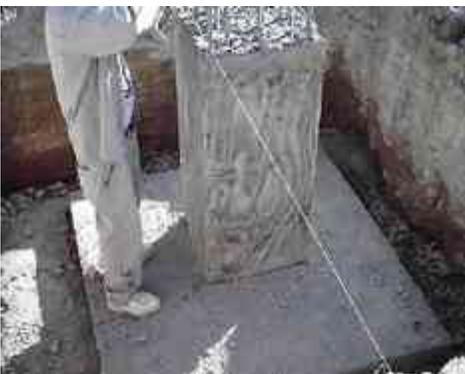
Fig.88. Zapatas aisladas. /Autor.
