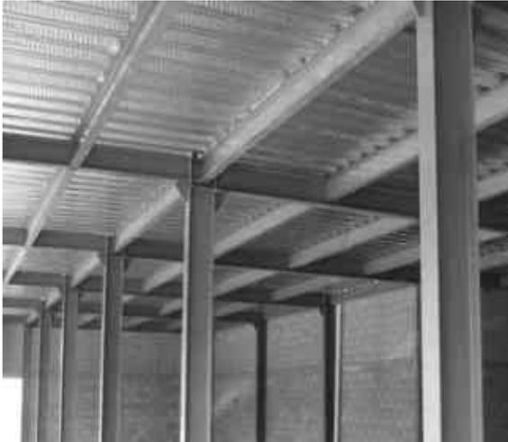
Fig.89. Losacero y estructuras metálicas. Fuente: Autor.
