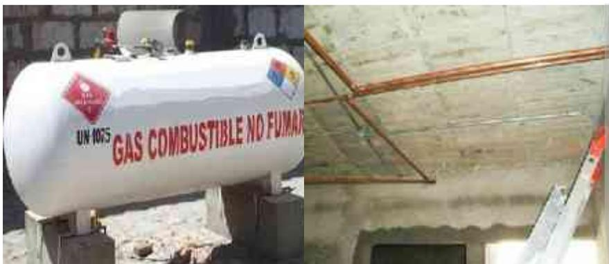
Fig.86. Tanque estacionario y tuberías de gas de cobre/RS.V.
