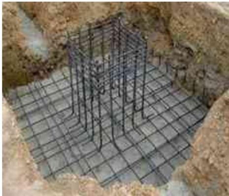
Fig.87. Acero de refuerzo en zapata aisladas. /Autor.
