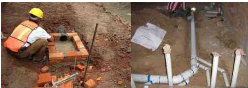
Fig.83. Registros de tabique rojo y red de drenaje de PVC. Fuente: Autor.
