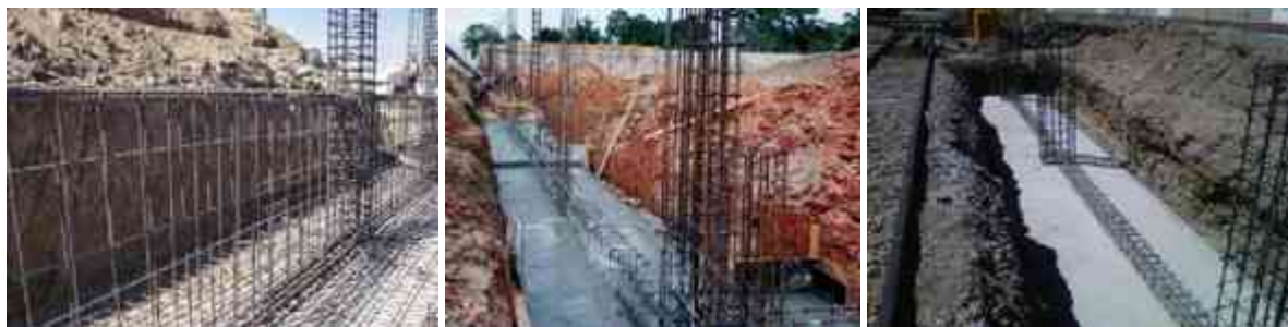
Imagen 24 – Grupo de fotos obtenidas de google, donde se muestran los distintos procesos constructivos de las zapas aisladas, así como la habilitación del acero para columnas de concreto. ( http://inscripcionesubj.blogspot.mx/ - http://www.aguascalientes.gob.mx/ - 10/03/15)
