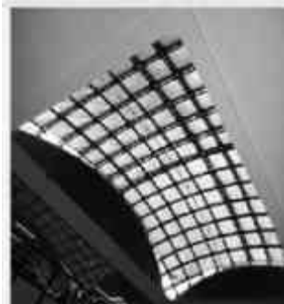
Imagen.16 Vista de la cubierta. Tomada el 20/10/14 por RGV,
