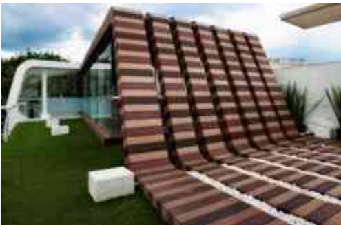
Imagen.26 Vista de la cubierta de madera. Recuperada de: http://www.obrasweb.mx/arquitectura/2011/12/09/un-cafe-en-las-alturas
