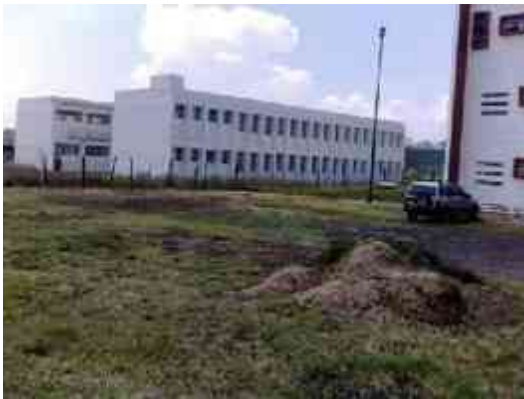
Imagen 68. Terreno (4), ubicado a un costado de Archivo General. Foto tomada el 24/09/14 por RGV.
