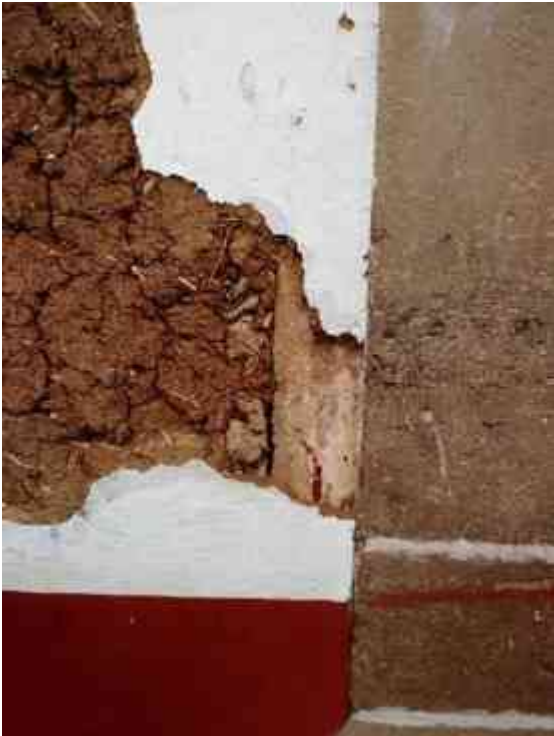
Imagen CVIII: Empleo de castillo de concreto y muro de adobe. Fotografía: Leonardo Valencia Arceo. Pátzcuaro Michoacán. 11/07/15
