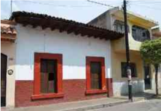
Imagen CXXIV: Construcción vernácula hecha con adobe, madera y teja. Fotografía: Leonardo Valencia Arceo. 12/04/15
