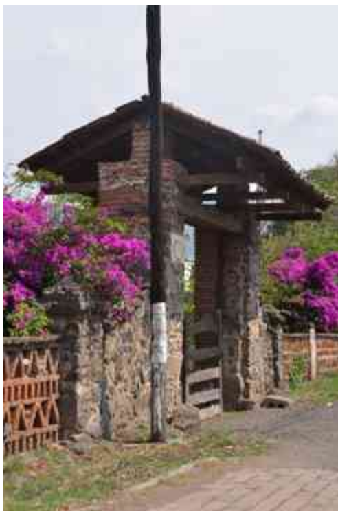
Imagen CXXII: Acceso, arquitectura tradicional, realizado a base de mamposteado de piedra, estructura de madera y techo a dos aguas de teja. Fotografía: Leonardo Valencia Arceo. 12/04/15
