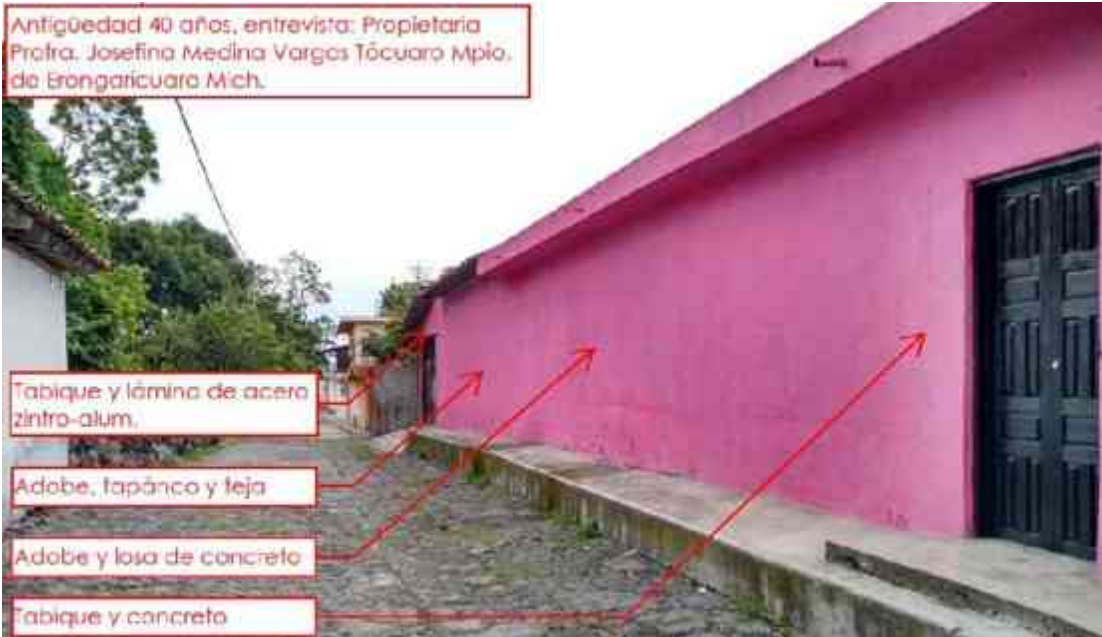
Imagen CXVII: Casa con 40 años de antigüedad en donde se emplearon diversos sistemas constructivos, como es el caso del adobe y el concreto y el tabique y el concreto. Fotografía: Leonardo Valencia Arceo. Tócuaro Mpio. de Erongarícuaro Michoacán. 12/07/15
