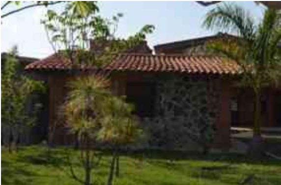
Imagen CXXVIII: Construcción vernácula hecha con adobe, madera y teja. Fotografía: Leonardo Valencia Arceo. 12/04/15
