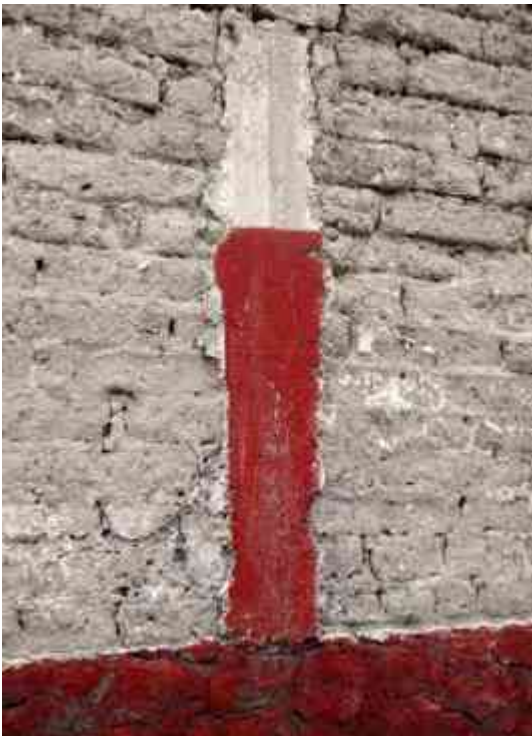
Imagen CVIII: Empleo de castillo de concreto y muro de adobe. Fotografía: Leonardo Valencia Arceo. Pátzcuaro Michoacán. 11/07/15
