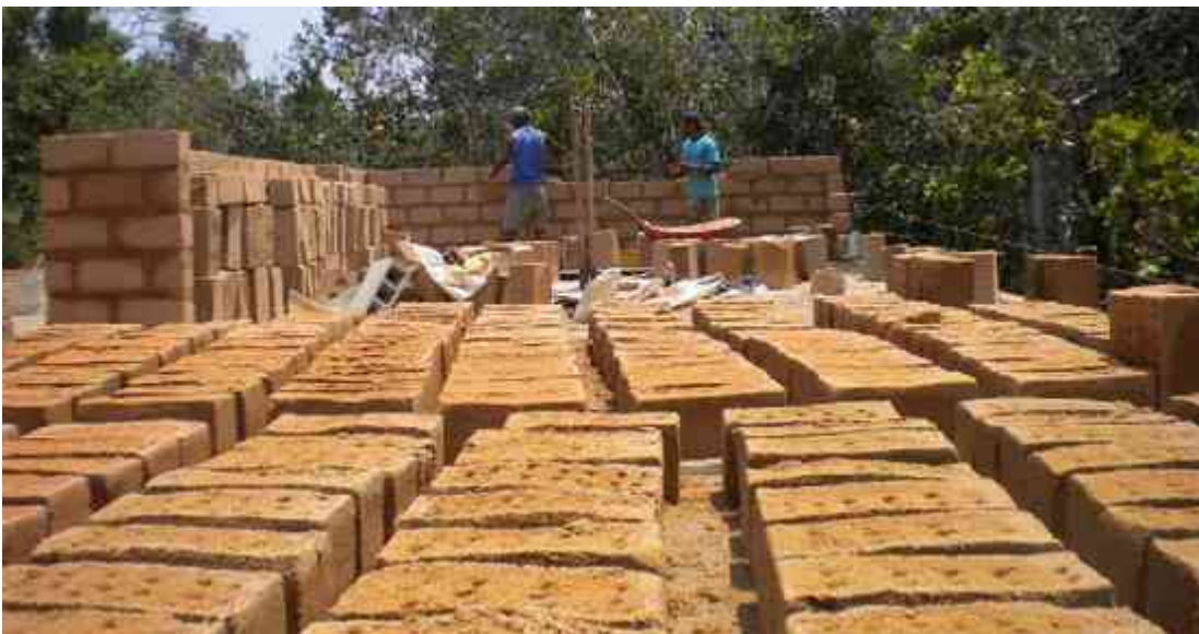
Imagen LXXXIII: Obtención del adobe. Fuente: http://www.larutanatural.eu/wp-content/uploads/construccion-adobe-barro.jpg . (Último acceso: 21/05/15)
