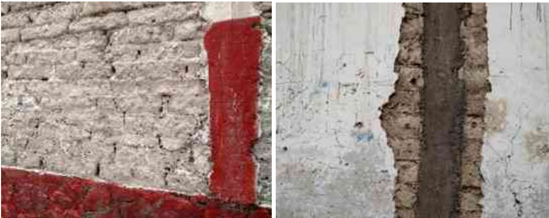
Imagen XCIII: Empleo de castillo de concreto y muro de adobe, sobre mamposteo de piedra braza. Fotografía: Leonardo Valencia Arceo, Jarácuaro Mpio. de Erongarícuaro Michoacán. 12/07/15
