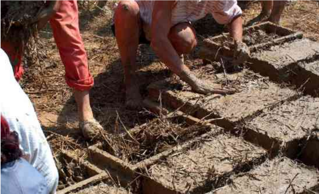
Imagen LXXXI: Elaboración del adobe. Fuente: http://upload.wikimedia.org/wikipedia/commons/2/2a/RomaniaDanubeDelta_MakingMaterialForCONstru-cting0002jpg.JPG . (Último acceso: 21/05/15)
