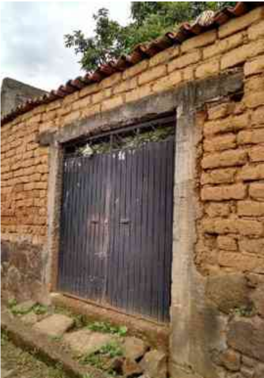
Imagen CX: Empleo de castillo de concreto armado y muro de adobe. Fotografía: Leonardo Valencia Arceo. Jarácuaro Mpio. de Erongarícuaro Michoacán. 12/07/15
