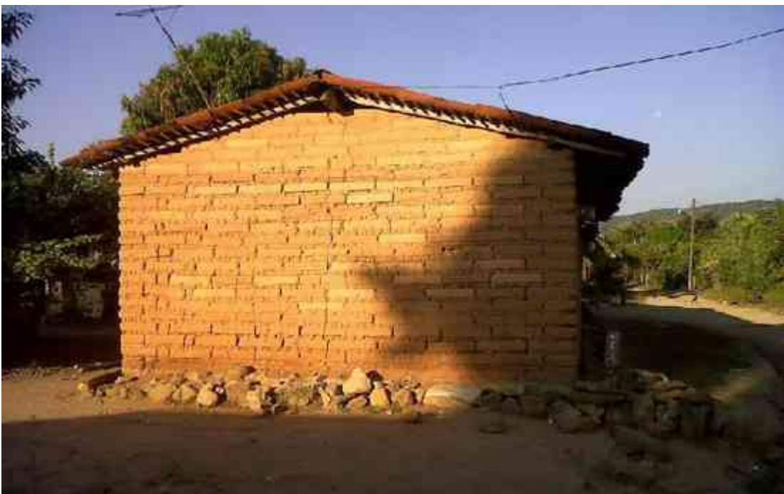
Imagen IX: Construcción donde se observa el empleo de materiales tradicionales como adobe, madera y teja. Fuente: http://www.panoramio.com/photo/68737972 . (Último acceso: 21/05/15)
