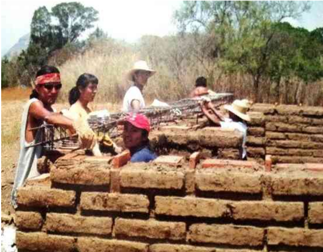
Imagen CVI: Armado de dala de concreto, se utilizó ladrillo para unir al adobe. Fuente: AGUILAR PRIETO, Berenice. Construir con adobe, fundamentos, reparación de daños y diseño contemporáneo. México: Trillas, 2008.
