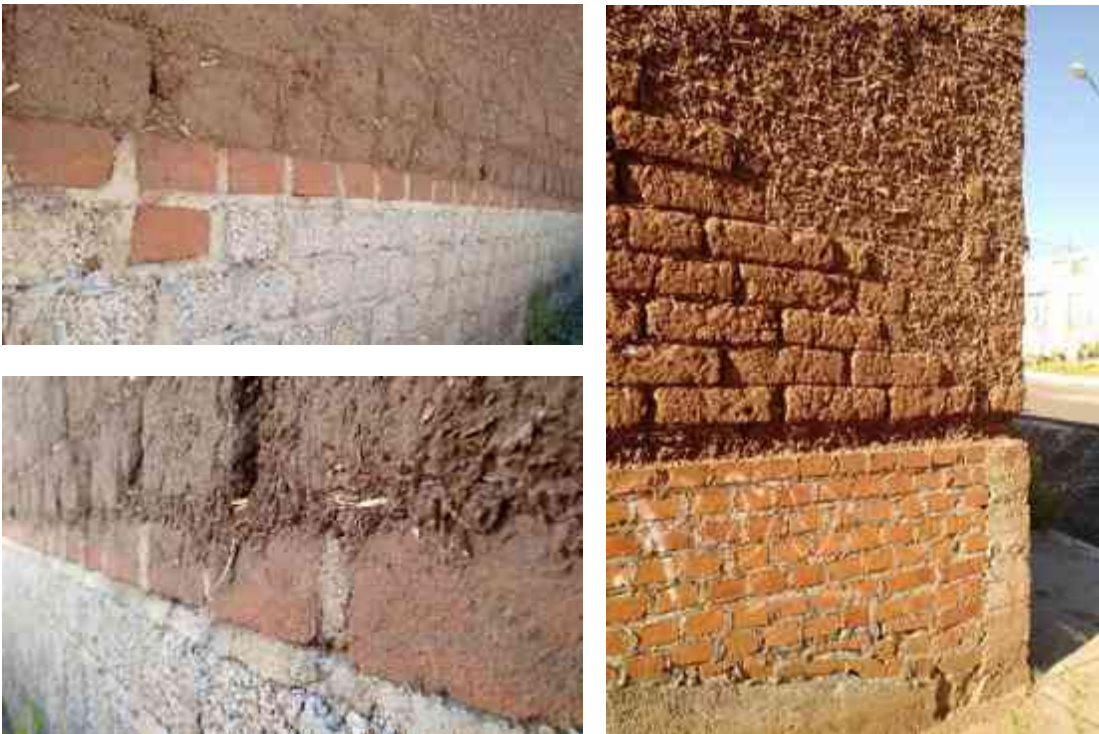
Imagen CXV: Empleo de tabique rojo recocado, para unión de muro de adobe, sobre rodapié de tabicón. Fotografía: Leonardo Valencia Arceo, Morelia Michoacán. 16/08/15
