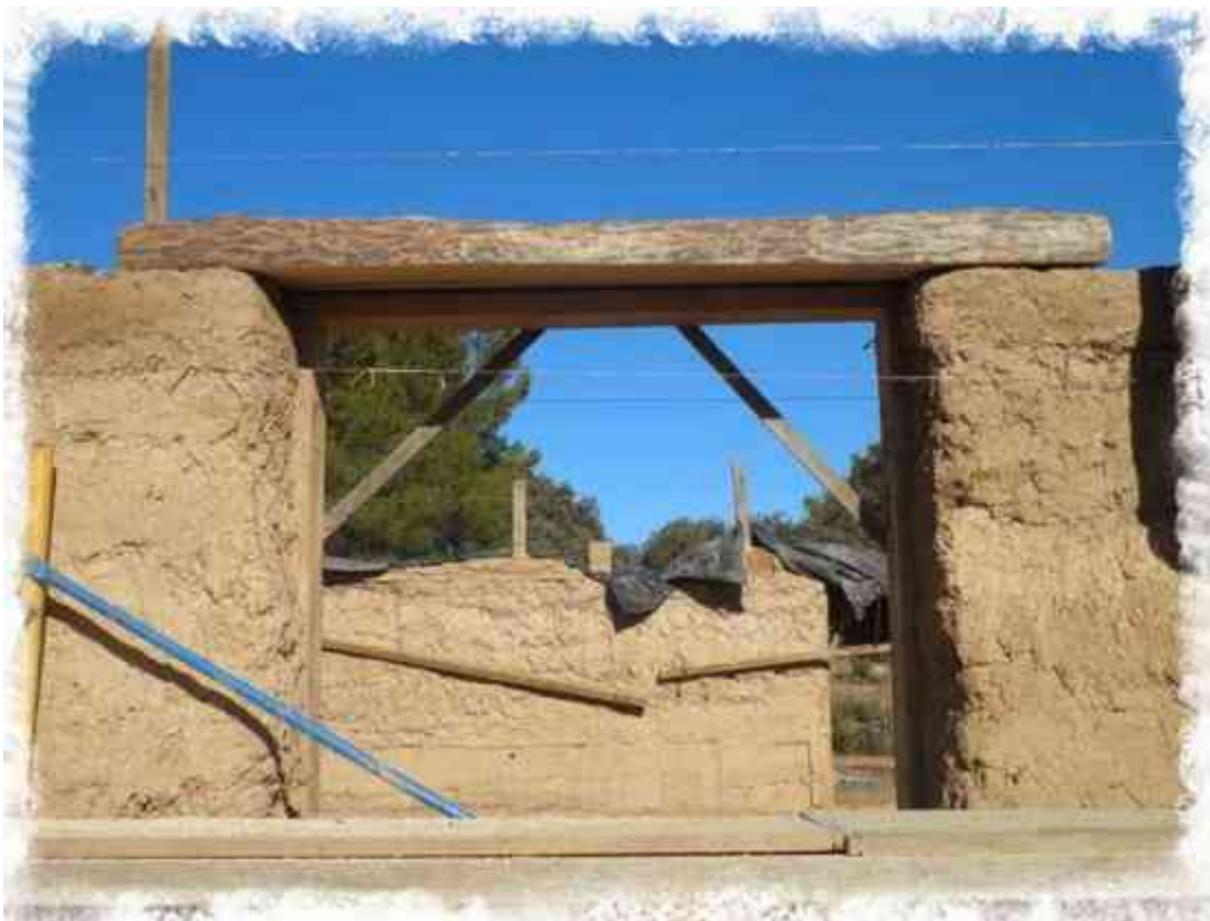
Imagen XCI: Dinteles de puertas y ventanas a base de viga de madera. Fuente: http://pajaybarro.blogspot.mx/2014/02/colocando-dinteles.html . (Último acceso: 21/05/15)
