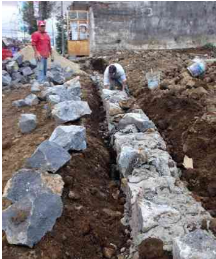
Imagen LXXXV: Mamposteo de piedra brasa. Fuente: http://2.bp.blogspot.com/-YMvMe0SvFPg/UrOZA-JoZal/AAAAAAAAAMo/0YvHWvrqllM/s1600/IMG_0078.jpg . (Último acceso: 21/05/15)
