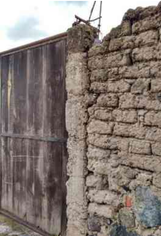
Imagen CX: Empleo de castillo de concreto armado y muro de adobe. Fotografía: Leonardo Valencia Arceo. Jarácuaro Mpio. de Erongarícuaro Michoacán. 12/07/15
