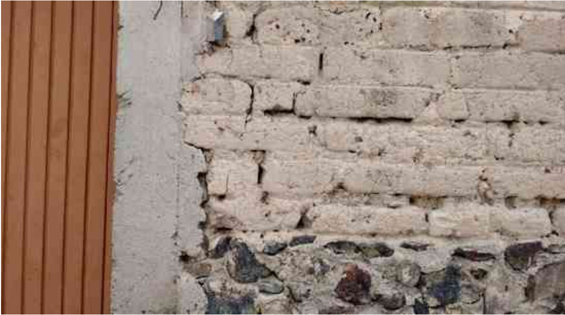
Imagen CXII: Empleo de castillo de concreto y muro de adobe, sobre mamposteo de piedra braza. Fotografía: Leonardo Valencia Arceo, Tócuaro Mpio. de Erongarícuaro Michoacán. 12/07/15
