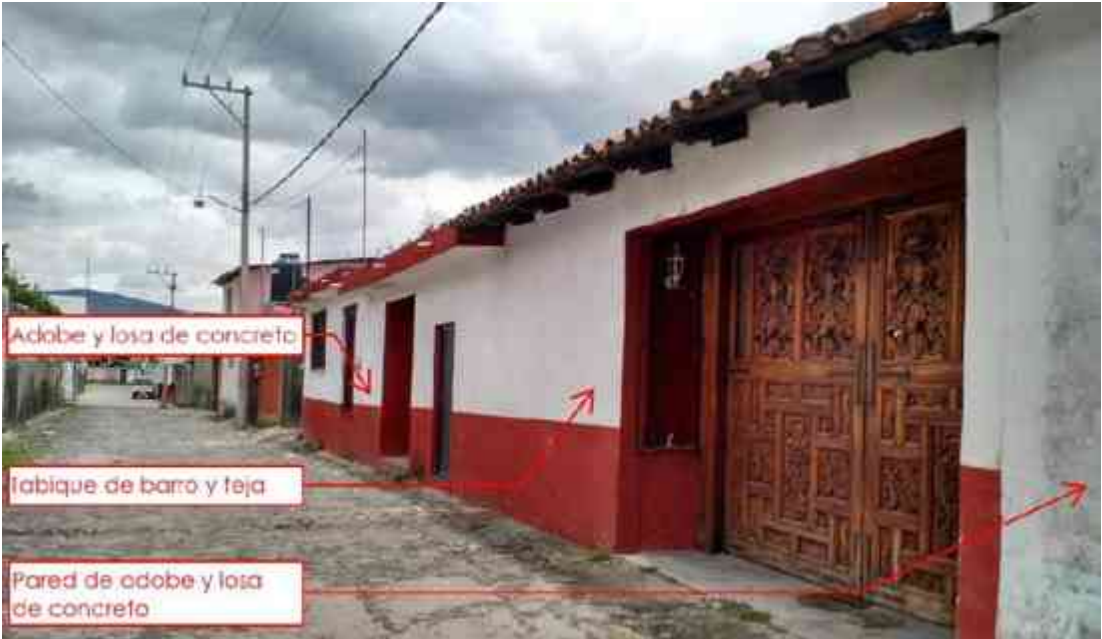
Imagen CXVIII: Casa en donde se emplearon diversos sistemas constructivos, como es el caso del adobe y el concreto y el tabique y el concreto. Fotografía: Leonardo Valencia Arceo. Tócuaro Mpio. de Erongarícuaro Michoacán. 12/07/15
