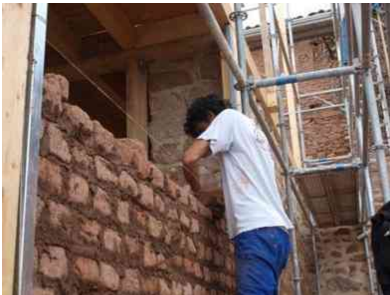
Imagen LXXXVI: Colocación de mamposteo de adobe. Fuente: http://cobijonatural.com/wp-content/uploads/2012/10/tierra-adobe.jpg . (Último acceso: 21/05/15)
