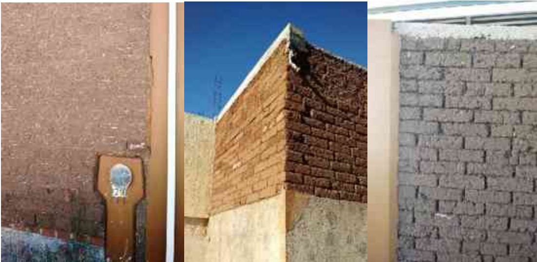
Imagen CXVI: Empleo de tabique rojo recocido, para unión de muro de adobe, sobre rodapié de tabicón, así como elementos de confinamiento en la cabecera del muro de adobe. Fotografía: Leonardo Valencia Arceo. Morelia Michoacán. 16/08/15
