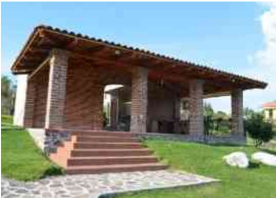
Imagen CXXVI: Construcción contemporánea hecha con tabique, acero y teja. Fotografía: Leonardo Valencia Arceo. 11/04/15
