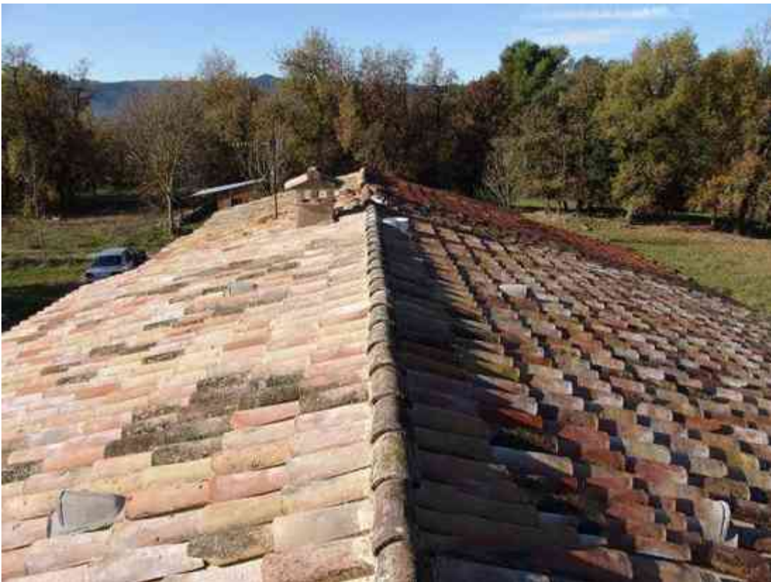
Imagen XCII: Techumbre a base de teja de barro colocada a dos aguas. Fuente: http://www.incofyr.com/techos-de-madera-rusticos-en-barcelona/ . (Último acceso: 21/05/15)
