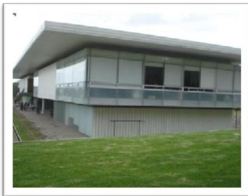
Imagen no. 30: Fachada de cristal y doble losa.
