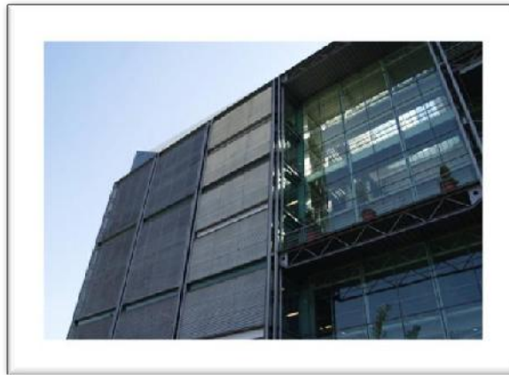
Imagen no. 27; Torre de ingeniería.
