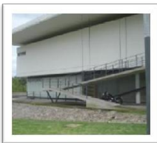
Imagen no. 28; Rampa del edificio administrativo.
