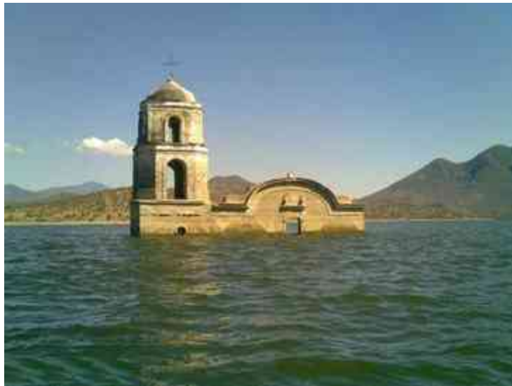
IMAGEN. Torre de iglesia inundada. (imagen tomada de google).
