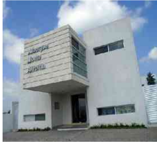
Ilustración 38 Fachada del proyecto Albergue Monte Alverna A.C. Fuente: IDEM
