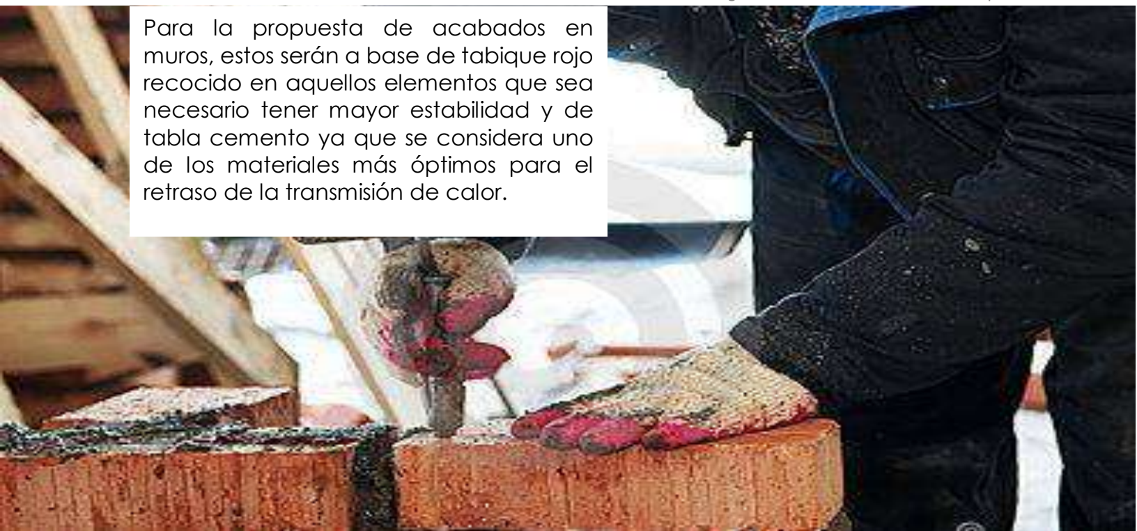
Fig.48. Levantamiento de muros de tabique.
