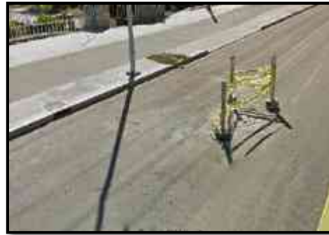
Foto 16 Tema: Coladera en Guarnición de Banqueta
