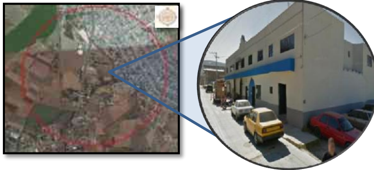
Foto 2 Tema: Edificio de Protección Civil, Seguridad Pública, Tránsito y Transporte
