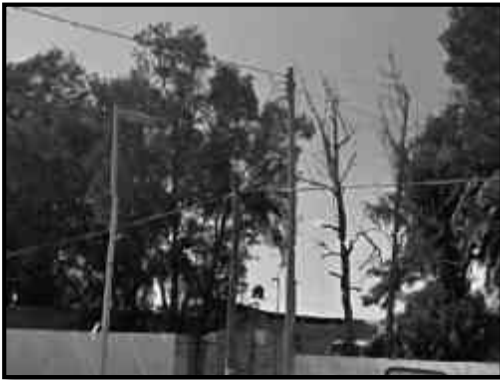
Foto 23 Tema: Poste de Telmex
