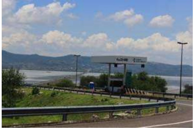
IMAGEN 44: ENTRONQUE A LA AUTOPISTA MORELIA-SALAMANCA A LA ALTURA DEL KM. 1.5 DE LA CARRETERA CUITZEO-HUANDACAREO. FOTOGRAFIA TOMADA EL 23 DE MAYO DE 2015 POR EL AUTOR DE LA TESIS.
