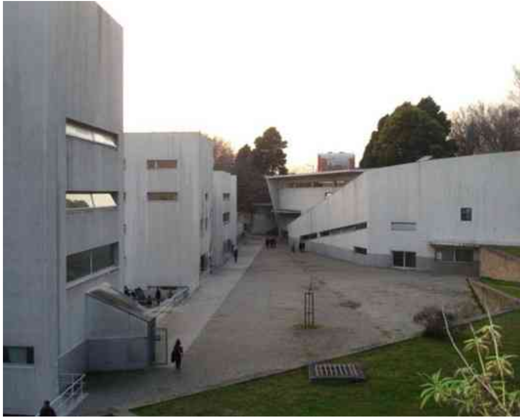
Ilustración 36. Vista del conjunto. Fuente: Goolge imágenes
