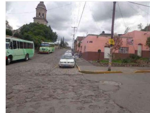
EMPEDRADO DETERIORADO POR EL PASO DEL TIEMPO Y FALTA DE MANTENIMIENTO
