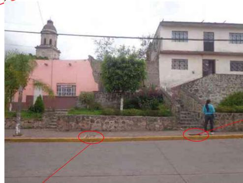
BANQUETAS FRACTURADAS A CAUSA DE LA FALTA DE MANTENIMIENTO
