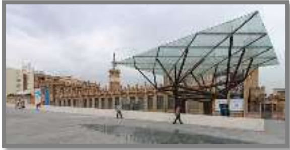
Imagen 41 Fachada Principal http://www.plataformaarquitectura.cl/cl/625333/centro-cultural-caixa-forum-barcelona-arata-isozaki/07-Abr-15
