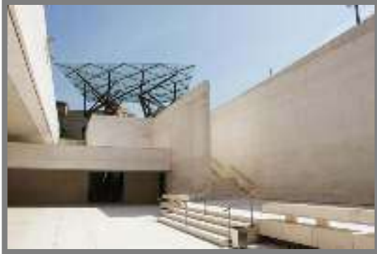
Imagen 38 La llegada al nivel principal del vestíbulo desde la calle http://www.archdaily.mx/mx/625333/centro-cultural-caixa-forum-barcelona-arata-isozaki -Abr-15
