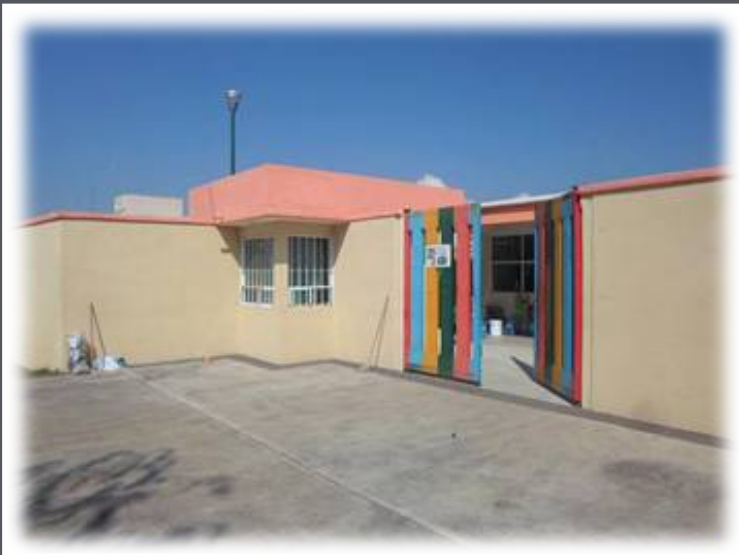
IMAGEN 15: Acceso Principal. fuente: F.M.Jiménez.M. fecha 25/11/2014.
