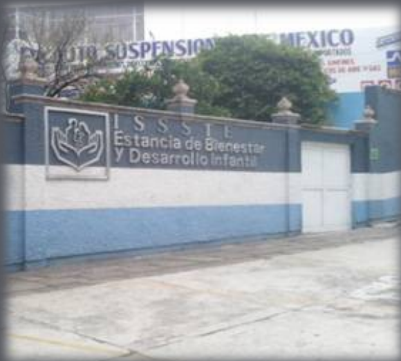
IMAGEN 25: Acceso Principal. fuente: F.M.Jiménez.M. fecha 27/11/2014.
