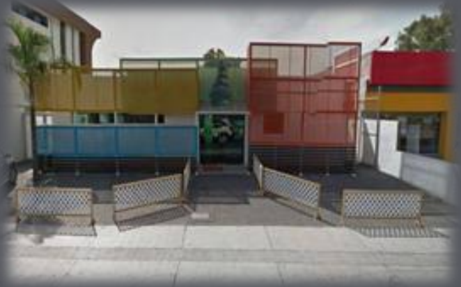
IMAGEN 20: Acceso Principal. fuente: F.M.Jiménez.M. fecha 26/11/2014.
