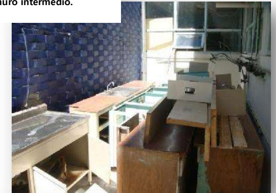
Ilustración 9. Retiro de mobiliario deteriorado.
