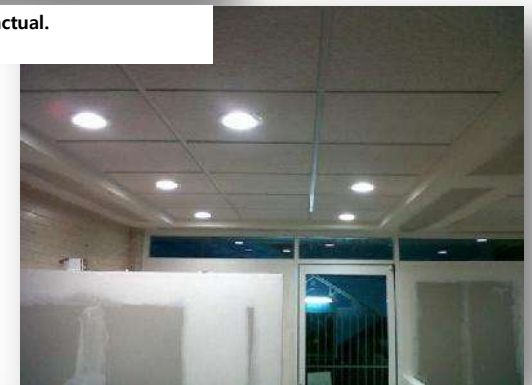
Ilustración 13. Luminarias, plafón, muros y cancelería.
