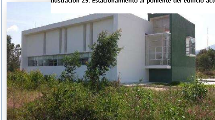
Ilustración 26. Fachada Nor-Poniente edificio actual.
