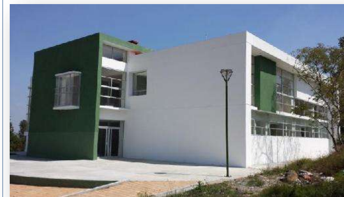
Ilustración 21. Fachada Sur-Poniente edificio actual.
