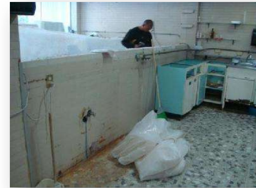
Ilustración 8. Demolición de muro intermedio.
