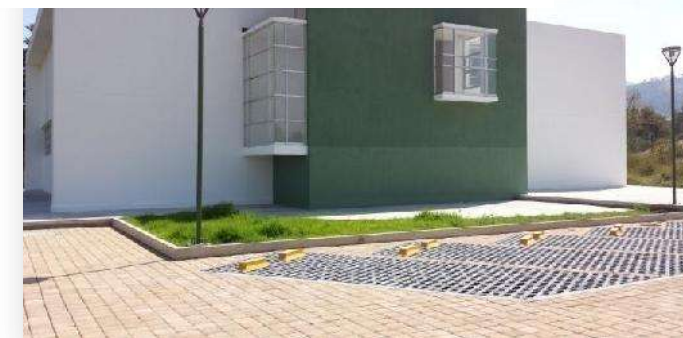
Ilustración 22. Fachada Poniente edificio actual.
