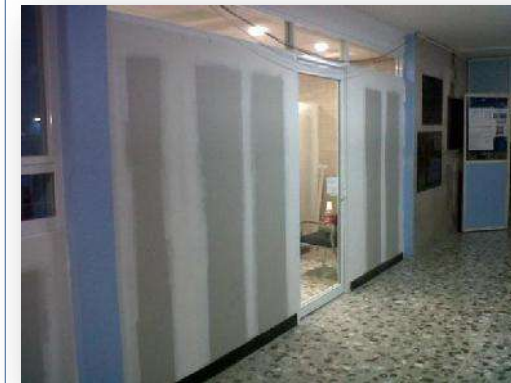
Ilustración 12. Acceso principal actual.
