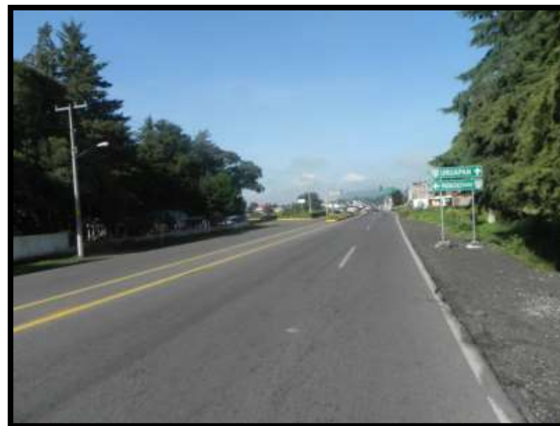
Ilustración 45. Vialidad principal Carretera federal Uruapan- Carapan
