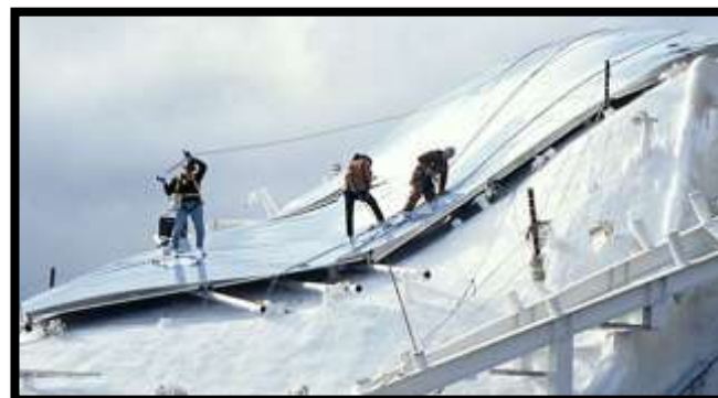
Ilustración 52. Estructura de acero y costillas de acero. Fuente: EL croquis pdf. (2001). El croquis pdf Frank Gehry. Optenido de http://www.arquba.com/libros-revistas/revista-el-croquis-117-frank-gehry/
