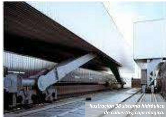
Ilustración 38 sistema hidráulico de cubiertas, caja mágica.
