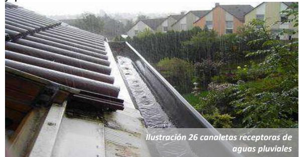
Ilustración 26 canaletas receptoras de aguas pluviales
