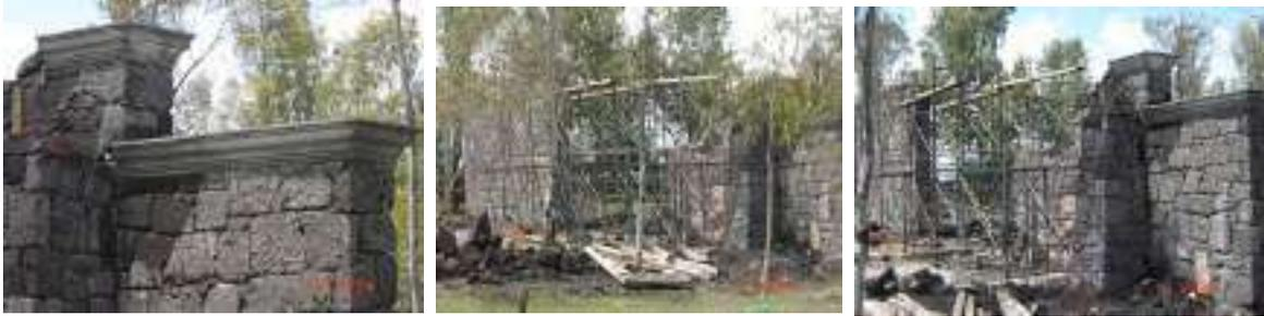
**Imagen 255 – 257.-** Imágenes de la Elaboración de trabajos en el Arco de Acceso y Colado de Molduras
