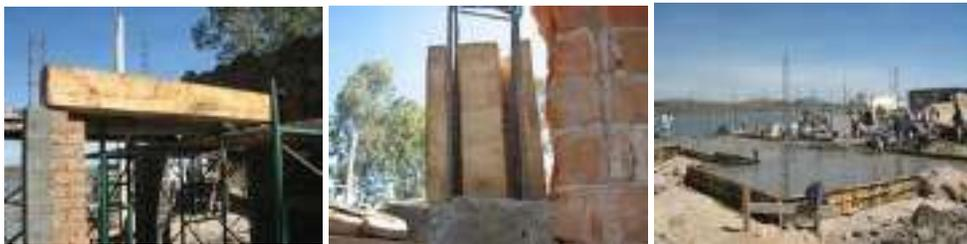
**Imagen 61 – 63.-** Imágenes de colocación de cerramientos de madera en gastronómico y colado de losa de cimentación de locales comerciales
