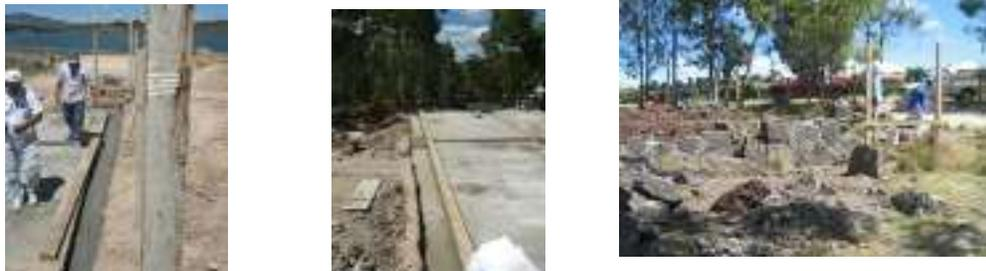
**Imagen 17 – 19.-** Imágenes de los recortes y cimbra de las plantillas de cimentación y la construcción de muros de mampostería de la capilla
