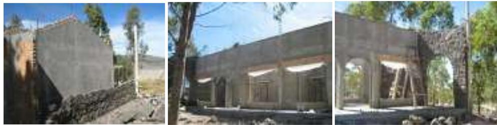
**Imagen 110 – 112.-** Imágenes de repellido de mezcla de cemento arena en gastronómico y sanitarios
