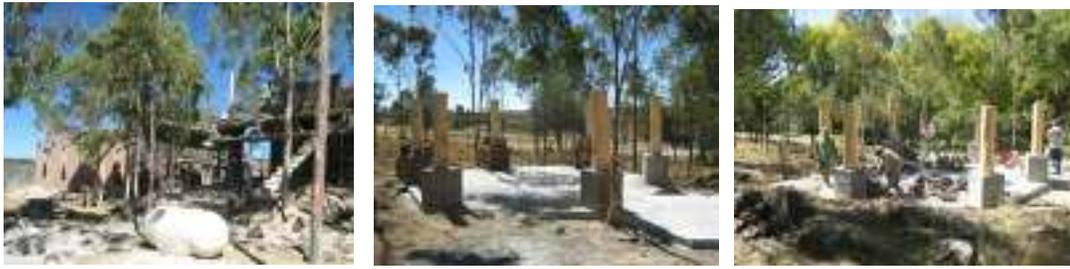
**Imagen 86 – 88.-** Imágenes de muros de piedra en gastronómico, cimbrado y colado de dados en columnas de madera, trabajo de piedra en bancas
