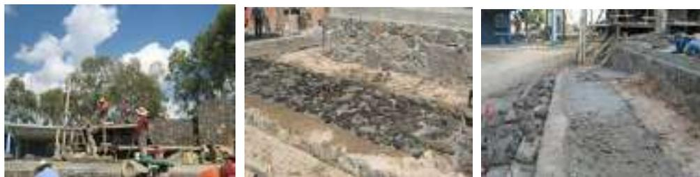
**Imagen 67 – 69.-** Imágenes de forjado de muro de piedra y de escalones de acceso en capilla abierta
