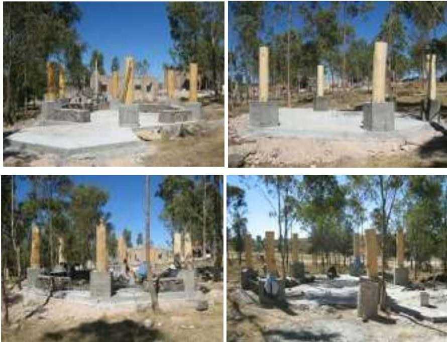
**Imagen 79 – 85.-** Imágenes de limpieza y preparación de columnas de madera con aplicación de pentaclorofenol y colocación en cenadores colando los dados de concreto armado de soporte
