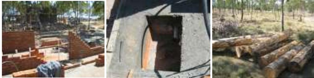
**Imagen 58 – 60.-** Imágenes de forjado de muros de tabique y forjado de registros sanitarios, preparación de troncos para columnas de madera
