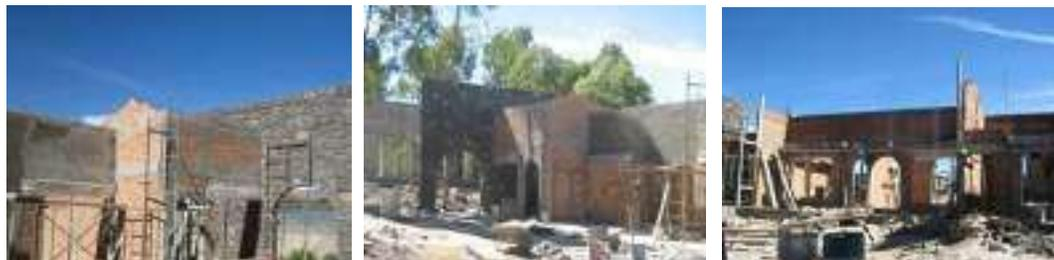
**Imagen 107 – 109.-** Imágenes de terminación de muros de tabique rojo recocido acabado común
