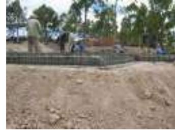
**Imagen 26 – 28.-** Imágenes de las Conformaciones de la Plantillas y las Losas de Cimentación
