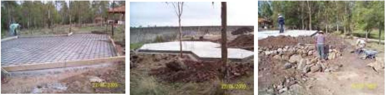
**Imagen 240 –242.-** Imágenes de la Elaboración de trabajos en Losas de Cimentación para Cenadores
