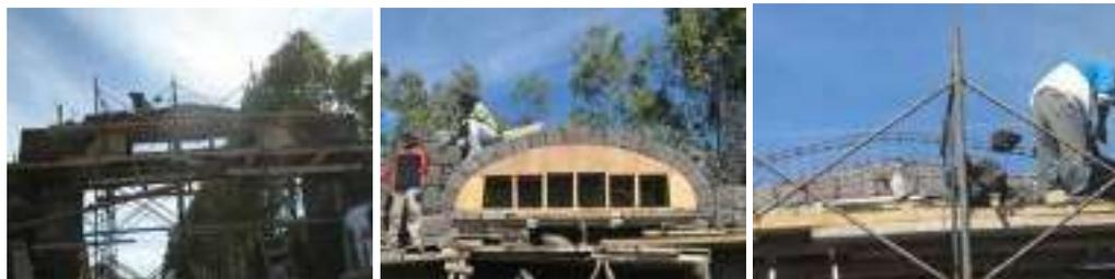
**Imagen 113 – 115.-** Imágenes de cimbrado y forjado de arcos centrales de piedra en acceso tipo y capilla abierta.
