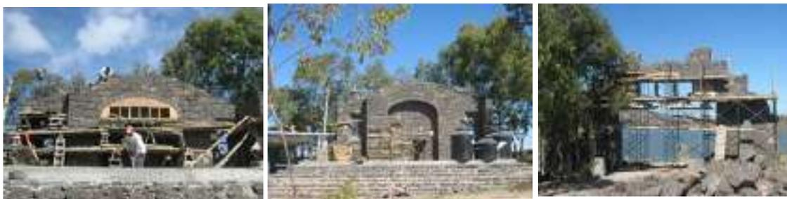
**Imagen 116 – 118.-** Imágenes de descimbrado del arco de piedra aparente en capilla abierta
