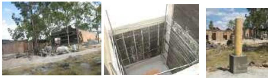
**Imagen 64 – 66.-** Imágenes de avance de trabajos en gastronómico cimbrado armado y colocación de columna de madera
