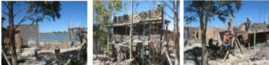
**Imagen 70 – 72.-** Imágenes de trabajos en muros de piedra de braza acabado aparente a dos caras
