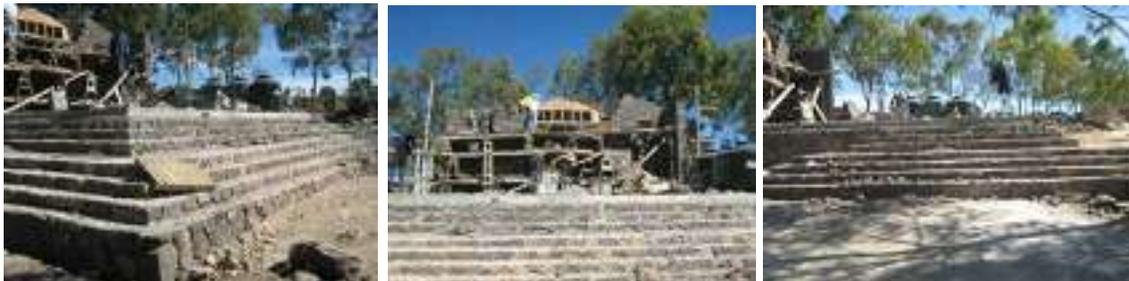
**Imagen 104 – 106.-** Imágenes de escalinata de piedra terminada y cimbra en arco central de capilla abierta
