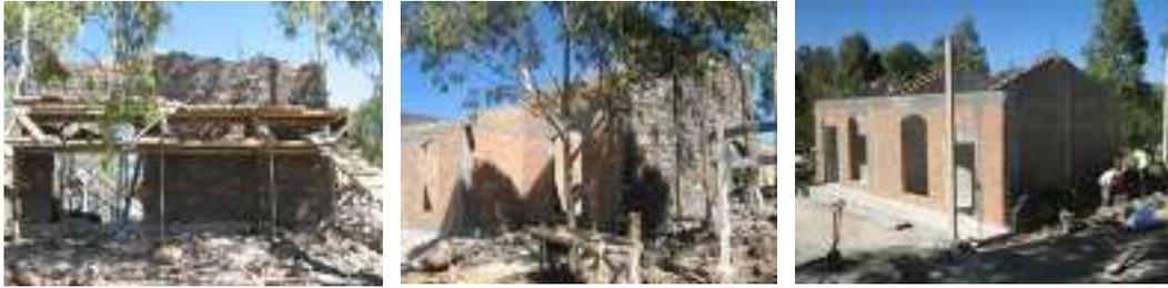
**Imagen 95 – 97.-** Imágenes de trabajos en muros de piedra de braza acabado aparente a dos caras
