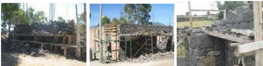
**Imagen 55 – 57.-** Imágenes de forjado de contrafuertes en acceso principal, forjado de muro de piedra aparente en capilla abierta y en locales
