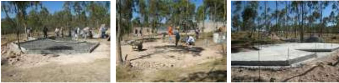
**Imagen 76 – 78.-** Imágenes de trabajos de conformación de plataformas, plantillas y armado, cimbrado y colado de losas de cimentación
