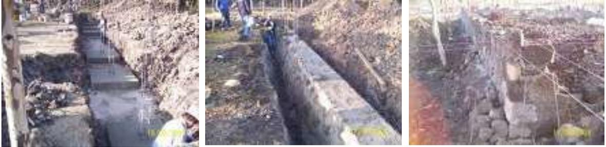
**Imagen 237 –239.-** Imágenes de la Elaboración del Cimentación en Arco de Acceso
