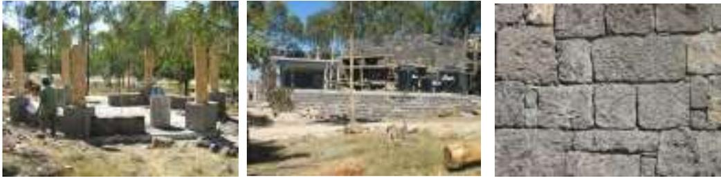
**Imagen 89 – 91.-** Imágenes de trabajo en escalinata de piedra en capilla, bancas en cenadores y detalle del trabajo de piedra braza aparente
