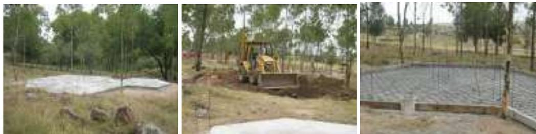
**Imagen 52 – 54.-** Imágenes de excavaciones con máquina, cimbrado armado y colado de losas de cimentación en cenadores
