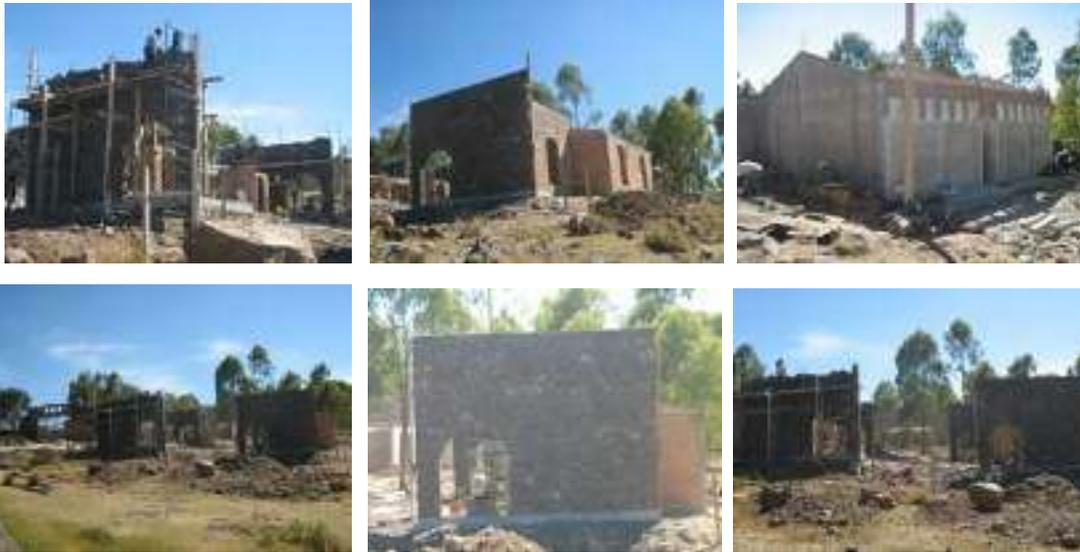
**Imagen 98 – 103.-** Imágenes de aplanados de mezcla en sanitarios, terminación de muros de piedra braza aparente en locales comerciales
