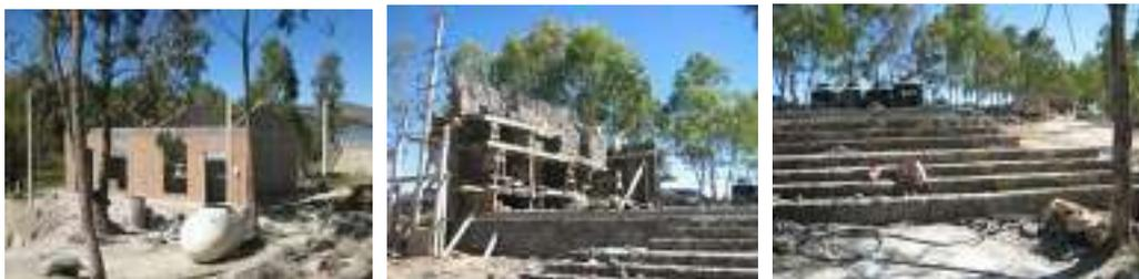
**Imagen 73 – 75.-** Imágenes de avance de muros de tabique en sanitarios, muros de piedra y escalones de piedra en capilla abierta
