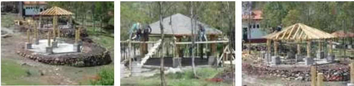
**Imagen 261 –263.-** Imágenes de la Colocación de Estructura de Madera en las Techumbres de los Cenadores
