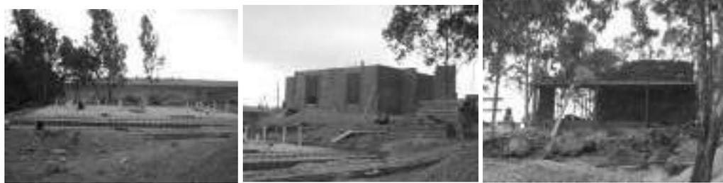
**Imagen 49 – 51.-** Imágenes de instalación sanitaria, muros y castillos y forjado de muro de piedra aparente en gastronómico
