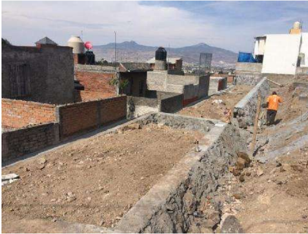
FOTO 40: CONSTRUCCIÓN DE MUROS DE CONTENCIÓN PARA PLATAFORMAS. FUENTE: ARQ. MARTIN CALDERON FECHA: 29 DE DICIEMBRE DE 2014.
