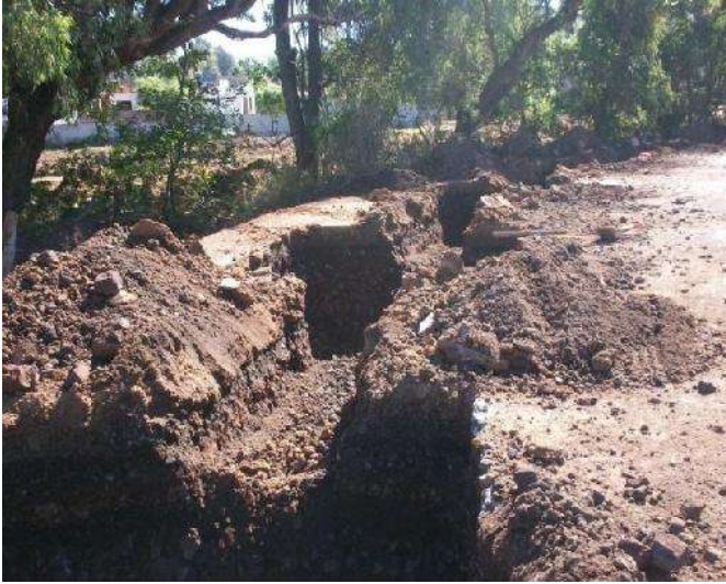
FOTO 9: EXCAVACIÓN A MANO EN TERRENO TIPO B EN CEPAS DE 1.40 m DE PROFUNDIDAD FUENTE: LOGÍSTICA ARQUITECTÓNICA. FECHA: 12 DE MARZO DE 2012
