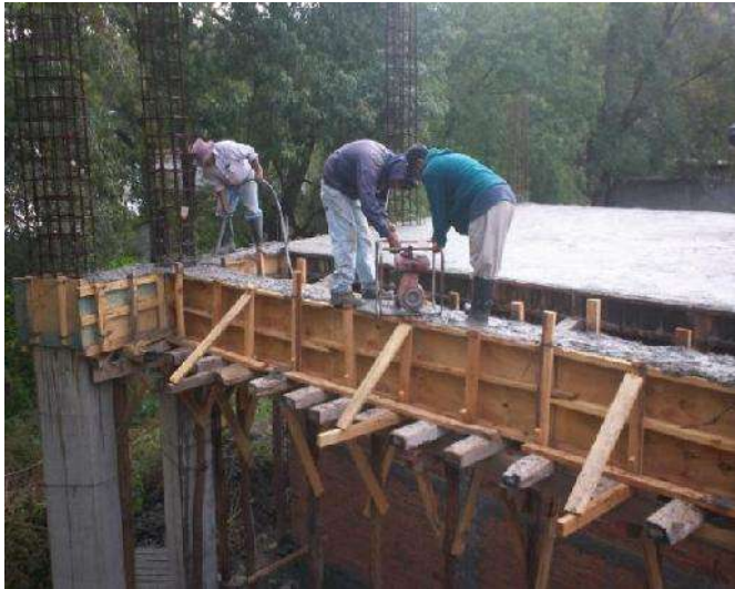
FOTO 23: COLADO Y VIBRADO DE CONCRETO CON MEDIOS MECANICOS EN TRABES.
