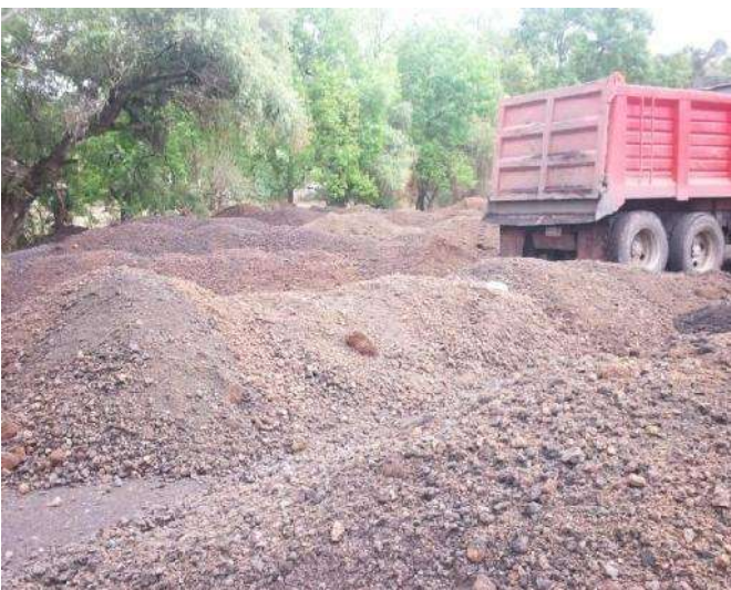
FOTO 6: CONSTRUCCIÓN DE PLATAFORMA FUENTE: LOGÍSTICA ARQUITECTÓNICA. FECHA: 03 DE FEBRERO DE 2012
