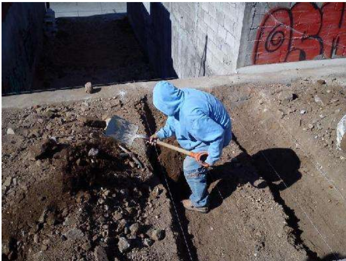
FOTO 42: EXCAVACIÓN POR MEDIOS MANUALES DE CEPAS PARA CIMENTACIÓN DE MUROS EN PISTA DE SKATE.
