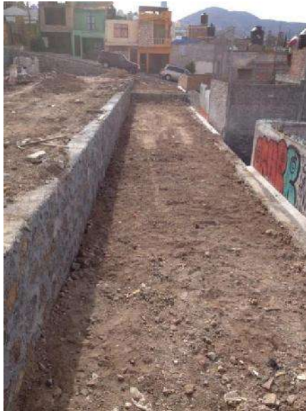
FOTO 41: RELLENO Y COMPACTACIÓN DE PLATAFORMAS. PLATAFORMA INFERIOR PARA CONSTRUIR PISTA DE SKATE.
