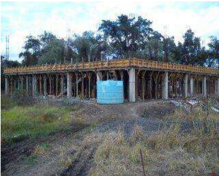
FOTO 19: HABILITADO, ARMADO Y CIMBRA APARENTE EN TRABES.
