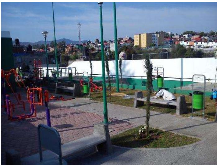
FOTO 79: OBRA TERMINADA. VISTA DEL GIMNASIO AL AIRE LIBRE, ÁREAS VERDES Y PASILLO DE CONCRETO ECOLÓGICO.
