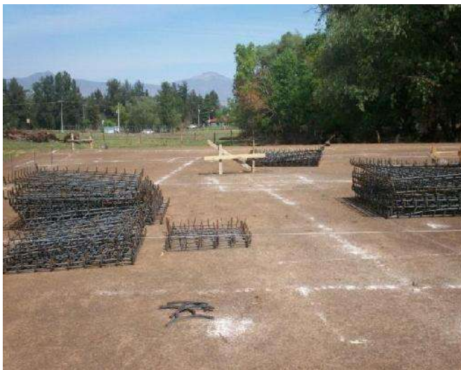
FOTO 8: TRAZO DE CIMENTACIÓN Y HABILITADO Y ARMADO DE ACERO DE REFUERZO FUENTE: LOGÍSTICA ARQUITECTÓNICA. FECHA: 05 DE MARZO DE 2012
