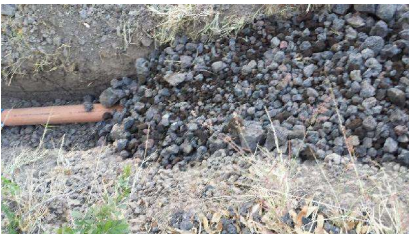
FOTO 30: COLOCACIÓN RELLENO TIPO FILTRO EN DENTELLON FUENTE: ARQ. MARTIN CALDERON FECHA: 23 DE DICIEMBRE DE 2014
