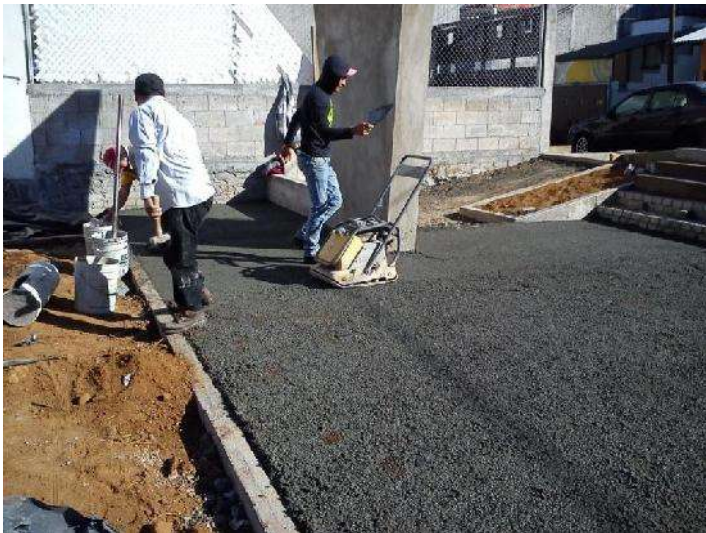
FOTO 67: VIBRADO DEL ECOCRETO CON EQUIPO MECANICO.
