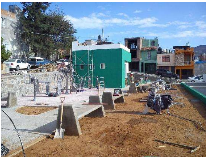
FOTO 74: COLOCACIÓN DE CAPA DE TIERRA VEGETAL DE 10 CM DE ESPESOR. FUENTE: ITZEL RIVERA FECHA: 12 DE MARZO DE 2015.
