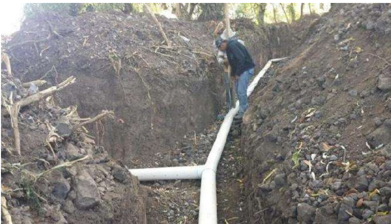
FOTO 29: COLOCACIÓN DE TUBERÍA DE PVC SANITARIO DE 6" CON PERFORACIONES DE 1/2" DE LA MITAD HACIA ABAJO. FUENTE: ARQ. MARTIN CALDERON FECHA: 19 DE DICIEMBRE DE 2014
