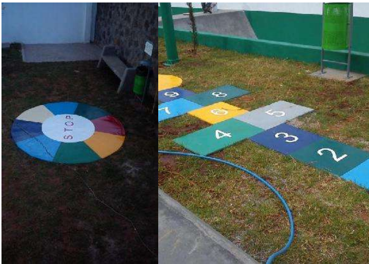
FOTO 70: JUEGOS INFANTILES EN AREA JARDINADA CONSTRUIDOS EN CONCRETO HECHO EN OBRA F'C=150 KG/CM2 CON ESPESOR DE 5 CM. ACABADO FINO Y TERMINADO EN PINTURA ACRILICA. FUENTE: ITZEL RIVERA FECHA: 30 DE MARZO DE 2015.
