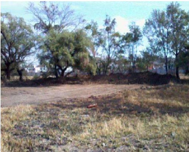
FOTO 4: LIMPIEZA DEL TERRENO. FUENTE: LOGÍSTICA ARQUITECTÓNICA. FECHA: 21 DE ENERO DE 2012
