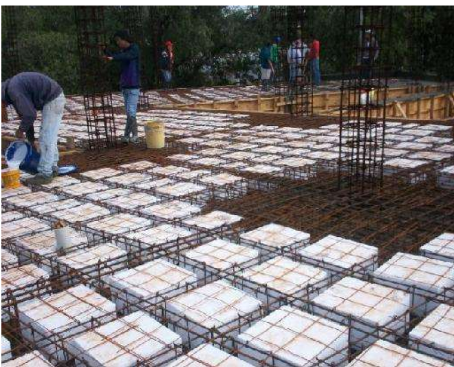
FOTO 22: COLOCACIÓN DE CASETONES EN LOSA RETICULAR. FUENTE: LOGISTICA ARQUITECTONICA FECHA: 22 DE OCTUBRE DE 2014
