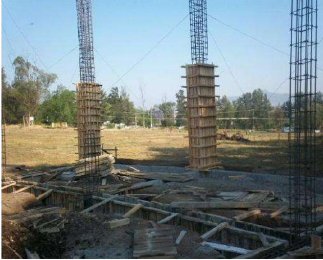
FOTO 15: CIMBRADO APARENTE Y COLADO DE COLUMNAS CON CONCRETO PREMEZCLADO F'c= 250\text{kg/cm}^2 .
