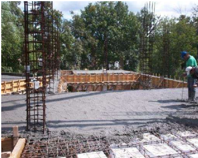
FOTO 24: COLADO Y VIBRADO DE CONCRETO CON MEDIOS MECANICOS EN LOSA DE ENTREPISO
