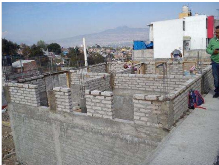
FOTO 56: CONSTRUCCIÓN DE TRABES INTERMEDIAS Y MUROS DE TABICON DE CONCRETO.
