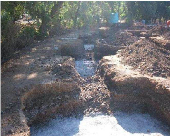
FOTO 11: CONSTRUCCIÓN DE PLANTILLA DE CONCRETO SIMPLE F'c=100 \text{ kg/cm}^2 DE 5CM DE ESPESOR. FUENTE: LOGÍSTICA ARQUITECTÓNICA. FECHA: 26 DE MARZO DE 2012
