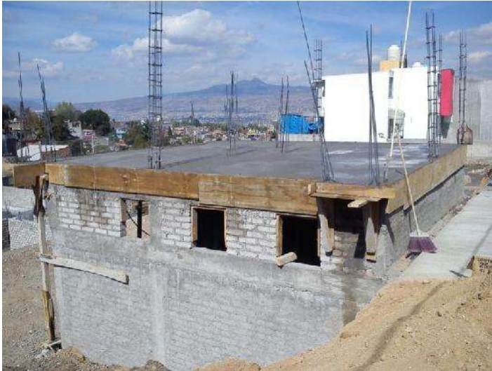
FOTO 57: CONSTRUCCIÓN DE LOSA DE CONCRETO ARMADO CON VARILLAS DEL #3 @20 CM EN AMBOS SENTIDOS DE 10 CM DE ESPESOR. F'c=250 Kg/cm 2 . FUENTE: ITZEL RIVERA FECHA: 24 DE ENERO DE 2015.
