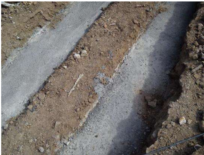
FOTO 44: CONSTRUCCIÓN DE PLANTILLA DE CONCRETO SIMPLE F'c= 100 \text{ KG/CM}^2 DE 5 CM DE ESPESOR PARA CIMENTACIÓN DE MUROS EN PISTA DE SKATE.
