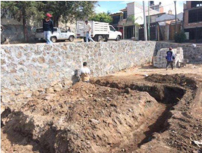
FOTO 52: EXCAVACIÓN EN CEPAS PARA CIMENTACIÓN DE CUBO DE SANITARIOS.
