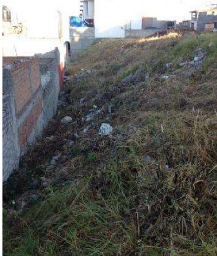
FOTO 34: LIMPIEZA DEL TERRENO FUENTE: ARQ. MARTIN CALDERON FECHA: 04 DE DICIEMBRE DE 2014.
