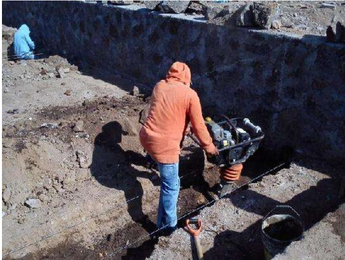
FOTO 43: COMPACTACIÓN DE CEPAS CON EQUIPO MECANICO BAILARINA PARA CIMENTACIÓN DE MUROS EN PISTA DE SKATE.
