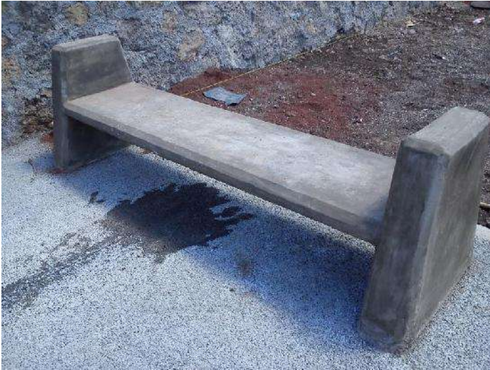
FOTO 73: BANCAS DE CONCRETO ARMADO CON LATERALES FUENTE: ITZEL RIVERA FECHA: 22 DE MARZO DE 2015.
