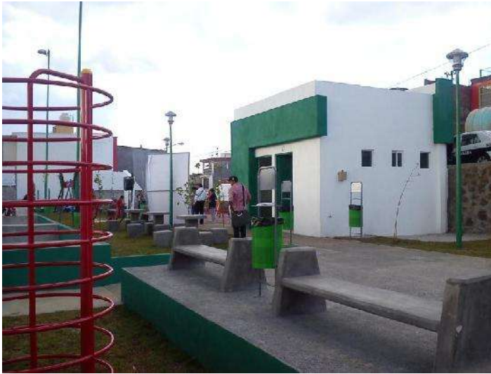
FOTO 78: OBRA TERMINADA. VISTA DEL CUBO DE SANITARIOS Y PASILLO DE CONCRETO ECOLÓGICO.
