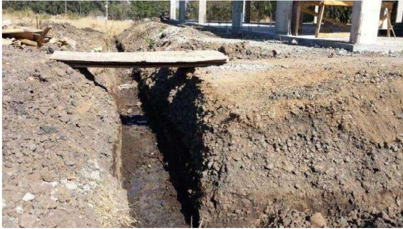
FOTO 28: EXCAVACIÓN PARA DENTELLÓN POR MEDIO DE MAQUINARIA RETROEXCAVADORA FUENTE: ARQ. MARTIN CALDERON FECHA: 13 DE DICIEMBRE DE 2014
