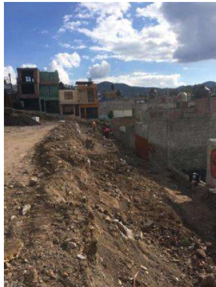
FOTO 37: NIVELACIÓN DEL TERRENO MEDIANTE CONSTRUCCIÓN DE PLATAFORMA INFERIOR. FUENTE: ARQ. MARTIN CALDERON FECHA: 08 DE DICIEMBRE DE 2014.
