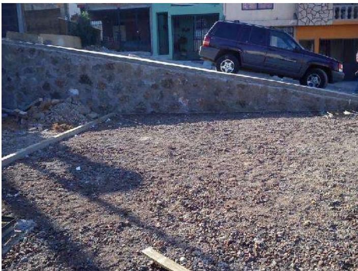
FOTO 65: COLOCACIÓN DE LA CAPA DE GRAVA SIN FINOS EN PASILLO. FUENTE: ITZEL RIVERA FECHA: 26 DE FEBRERO DE 2015.
