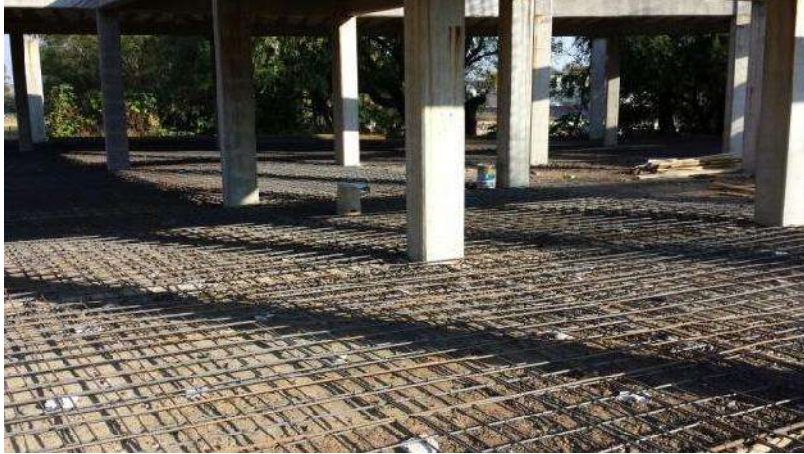
FOTO 25: ARMADO DE LOSA DE CIMENTACIÓN. VARILLA #3 @ 20 CM EN AMBOS SENTIDOS.
