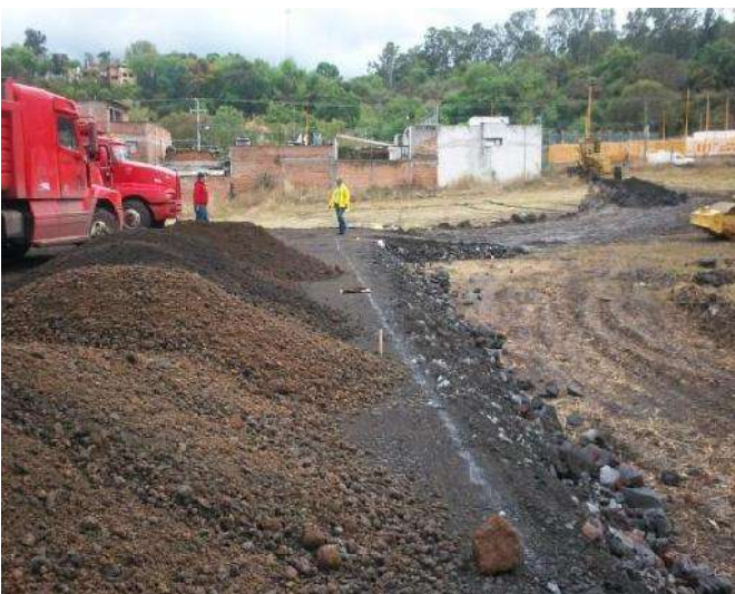
FOTO 7: CONSTRUCCIÓN DE PLATAFORMA FUENTE: LOGÍSTICA ARQUITECTÓNICA. FECHA: 03 DE FEBRERO DE 2012
