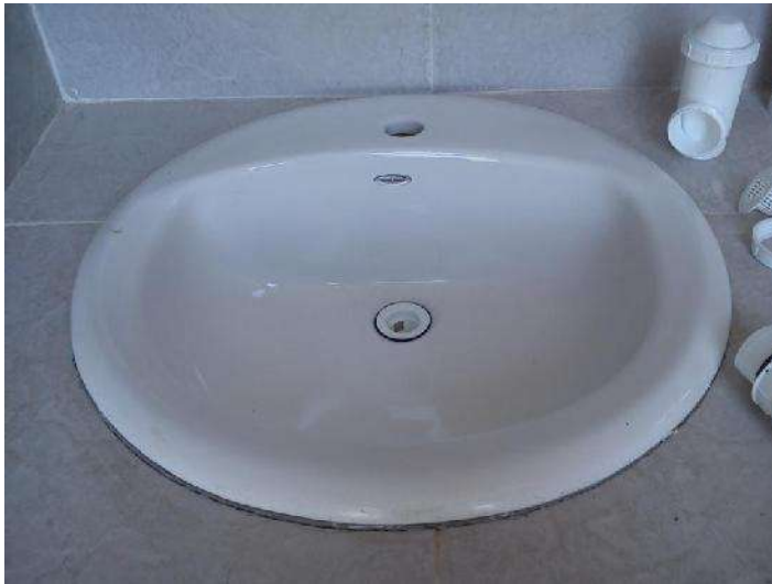
FOTO 62: COLOCACIÓN DE LAVABOS DE SOBRECUBIERTA MOD. RONDALYN COLOR BALNCO MARCA AMERICAN STANDARD.
