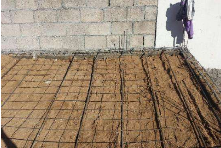
FOTO 49: COLOCACION DE MALLA ELECTROSOLDADA 6X6-10/10 PARA RECIBIR FIRME DE CONCRETO HECHO EN OBRA F'c=200 KG/CM 2 . FUENTE: ITZEL RIVERA FECHA: 04 DE FEBRERO DE 2015.
