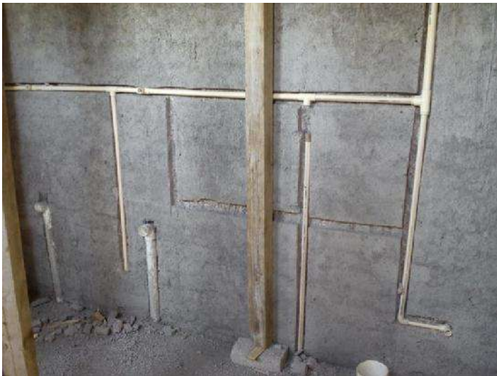
FOTO 59: INSTALACIÓN HIDRAULICA EN SANITARIOS A BASE DE TUBERÍA DE CPVC HIDRAULICO DE 3/4" EN MUROS Y SALIDAS DE SANITARIAS PARA MINGITORIOS Y WC EN PISO. FUENTE: ITZEL RIVERA FECHA: 27 DE ENERO DE 2015.
