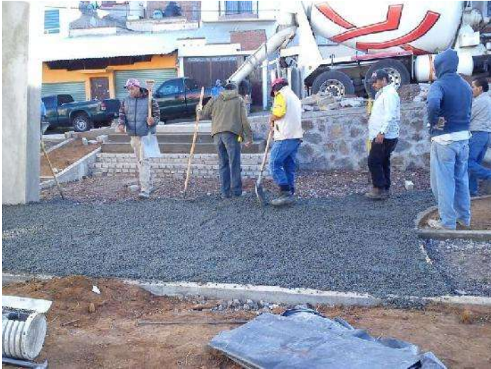
FOTO 66: COLADO Y ACOMODO DEL CONCRETO PREMEZCLADO ADICIONADO CON ECOCRETO POR MEDIOS MANUALES. PALAS Y RASTRILLOS.
