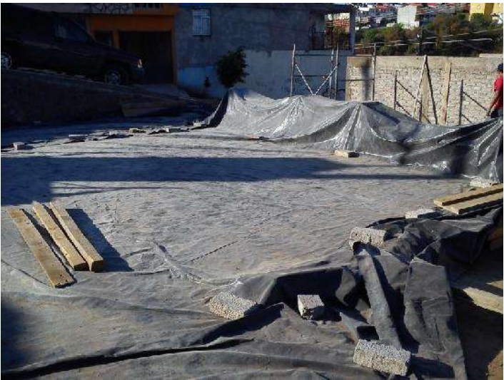
FOTO 68: CURADO Y PROTECCIÓN DEL ECOCRETO MEDIANTE PLASTICOS
