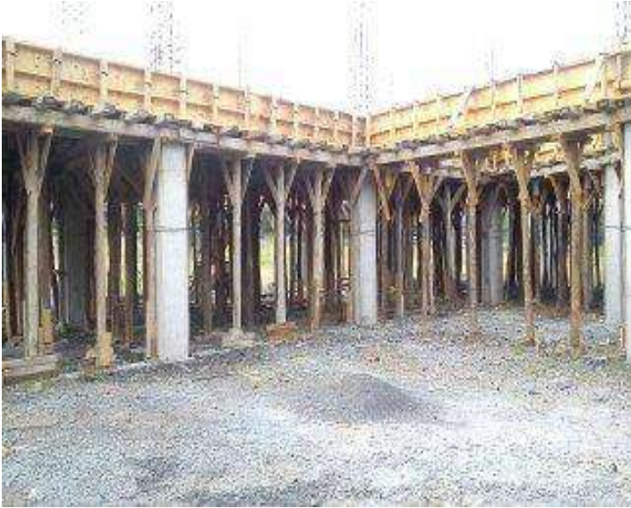
FOTO 20: HABILITADO, ARMADO Y Cimbra aparente en trabes y cimbra comun en losa reticular FUENTE: ITZEL RIVERA FECHA: 06 DE OCTUBRE DE 2014
