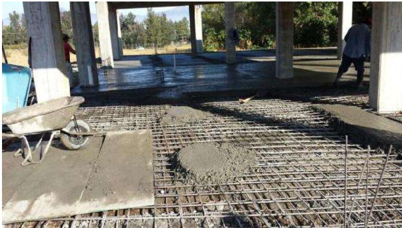
FOTO 26: COLADO DE LOSA DE CIMENTACIÓN CON CONCRETO PREMEZCLADO F'c=200 kg/cm 2 . FUENTE: ARQ. MARTIN CALDERON FECHA: 29 DE NOVIEMBRE DE 2014
