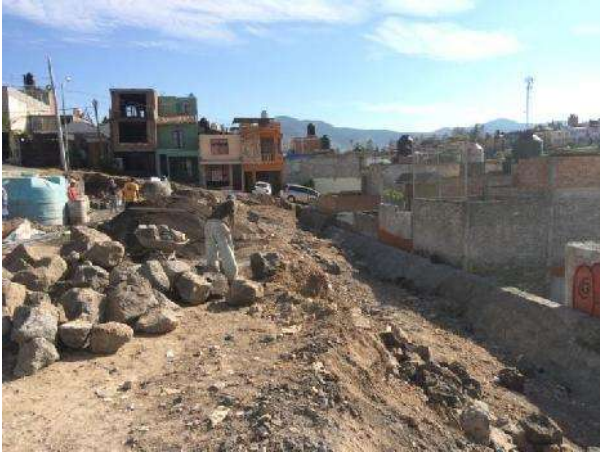
FOTO 38: CONSTRUCCIÓN DE MUROS DE CONTENCIÓN PARA PLATAFORMAS. FUENTE: ARQ. MARTIN CALDERON FECHA: 19 DE DICIEMBRE DE 2014.
