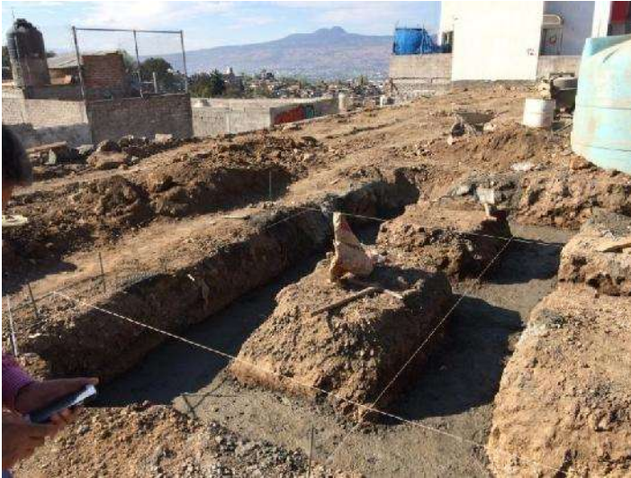
FOTO 53: PLANTILLA DE CONCRETO F'C=100 KG/CM2 HECHO EN OBRA DE 5 CM DE ESPESOR. EN CUBO DE SANITARIOS
