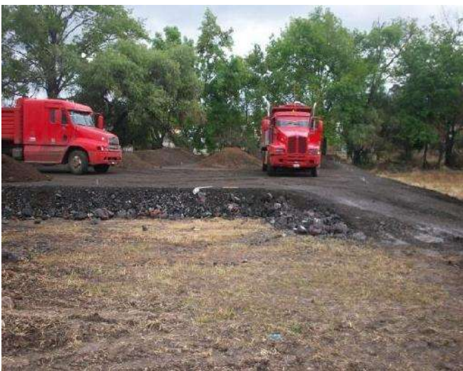
FOTO 5: CONSTRUCCIÓN DE PLATAFORMA FUENTE: LOGÍSTICA ARQUITECTÓNICA. FECHA: 01 DE FEBRERO DE 2012
