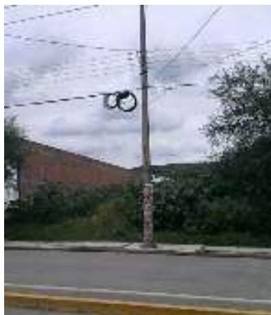
Imagen No. 33. Poste de CFE ubicado frente al terreno. Fuente: foto tomada por Juan Martínez.
