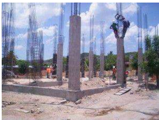
Imagen No. 43. Columnas de concreto armado.
