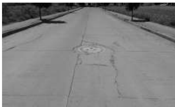
Imagen No. 32. Localización del drenaje municipal. Fuente: foto tomada por Juan Martínez.
