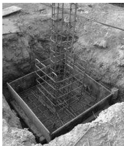
Imagen No. 42. Armado de una zapata aislada, se muestra la parte de columna, el dado y parte del armado de la losa.
