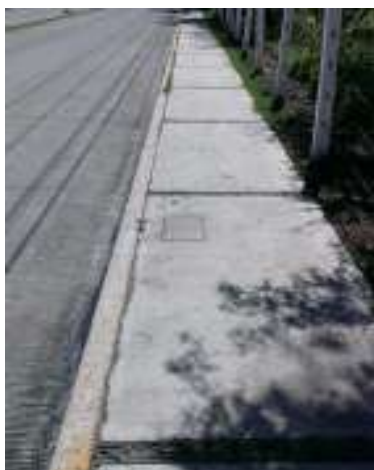
Imagen No. 36. Toma de agua potable. Fuente: Foto tomada por Juan Martínez
