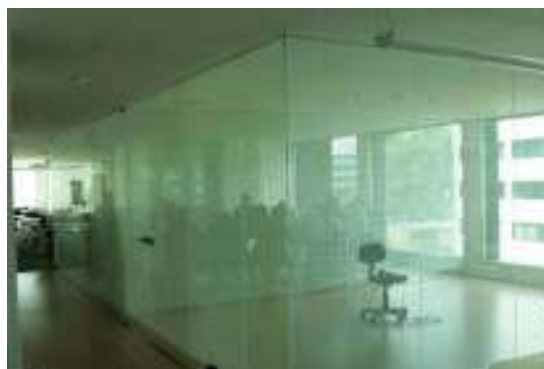
Imagen No. 49. Cristal templado utilizado en oficinas como muros divisorios. Fuente: http://cristel.com.mx/oficinas_cristel_cristal_templado.html
