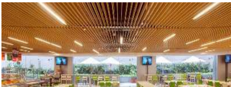
Imagen No. 51. El plafón Multicell es un plafón abierto y transparente.
