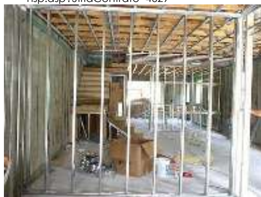
Imagen No. 49. Estructura de muro de tablaroca.
