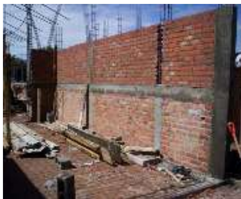
Imagen No. 48. Muro de tabique rojo.
