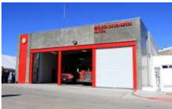
Imagen No. 2. Estación de bomberos en Tijuana con capacidad para 1 autobomba, 1 cisterna. Fuente: http://www.sandiegored.com/noticias/58826/Inauguran-estacion-de-bomberos-y-Cruz-Roja-en-Natura/
