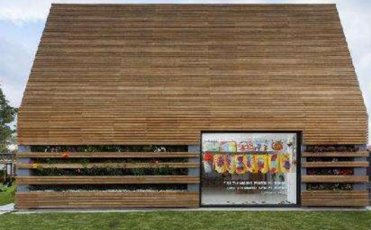
Imagen 15. Vista exterior, La Leroteca, La Caja de Arquitectos, http://www.arquitour.com/la-leroteca-lacaja-arquitectos/2014/05/
