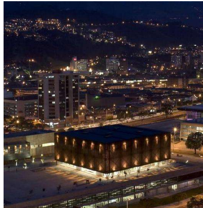
Imagen 6. Vista aérea, Centro de Convenciones, Medellín, foto: http://www.arquitour.com/centro-internacional-de-convenciones-de-medellin-daniel-bonilla-arquitectos/2010/10/
