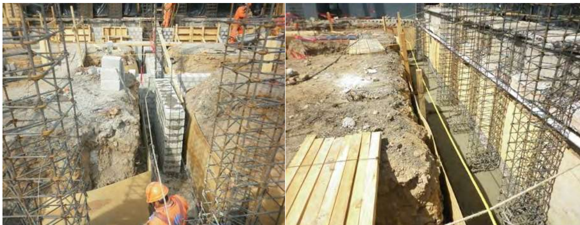
Fig. 4 y 5 habilitación de ademes y colocación de pasarelas 24
