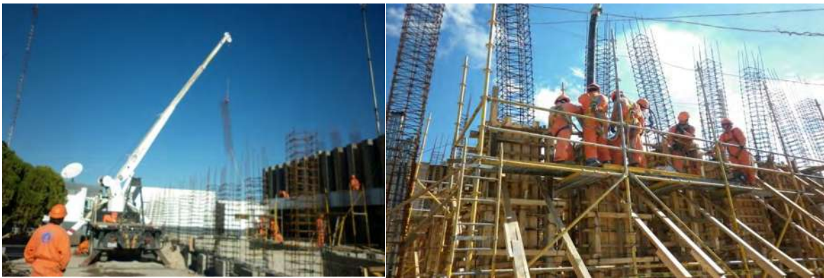
Fig. 8 y 9. Grúa nacional tipo titan y andamio tubular de roseta apoyados. 28
