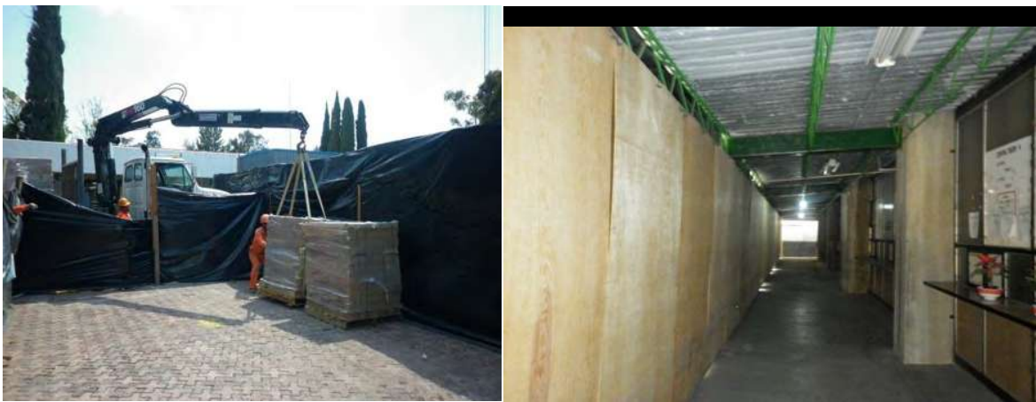
Fig.1y 2 Delimitación con plástico y triplay del perímetro de la obra y de la estiba de material. 21
