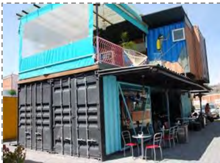
Ilustración 70: Reutilización de elementos para conformar la estructura.
