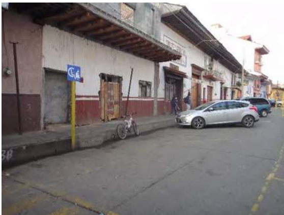
Ilustración 64. Señalamiento falta de mantenimiento y de proporción.
