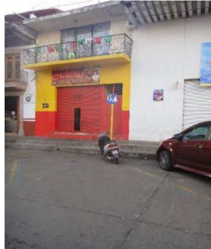
Ilustración 74. Señalización falta de mantenimiento
