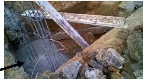
IMAGEN 80: Zapata corrida de concreto armado.
