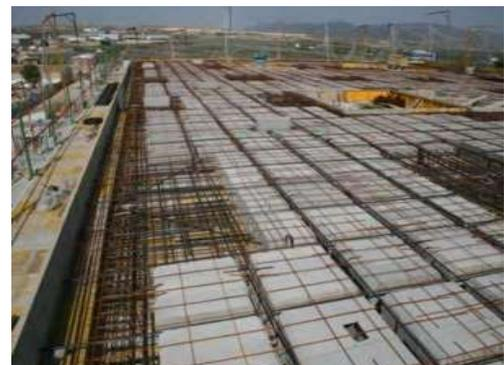
IMAGEN 64: Armado de losa nervada o reticular.
