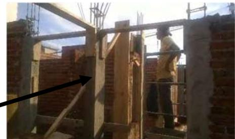
IMAGEN 81: Columnas y travesaños de concreto
