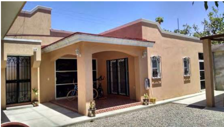
VISTA INTERIOR HACIA EL INGRESO Y TERRAZA
