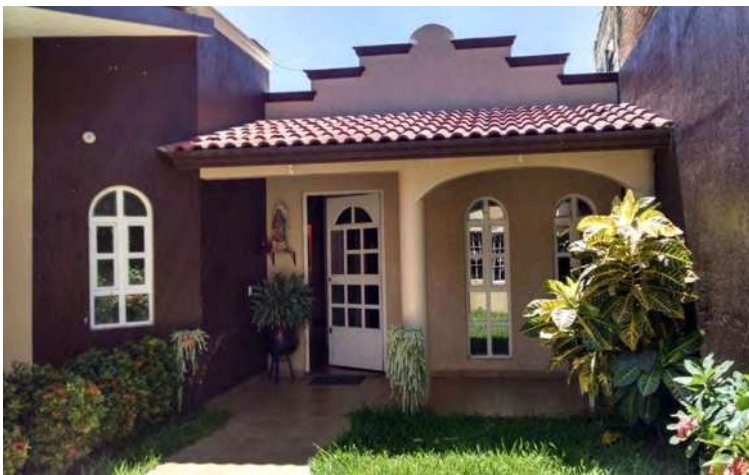
VISTA HACIA EL PORTICO DE INGRESO
