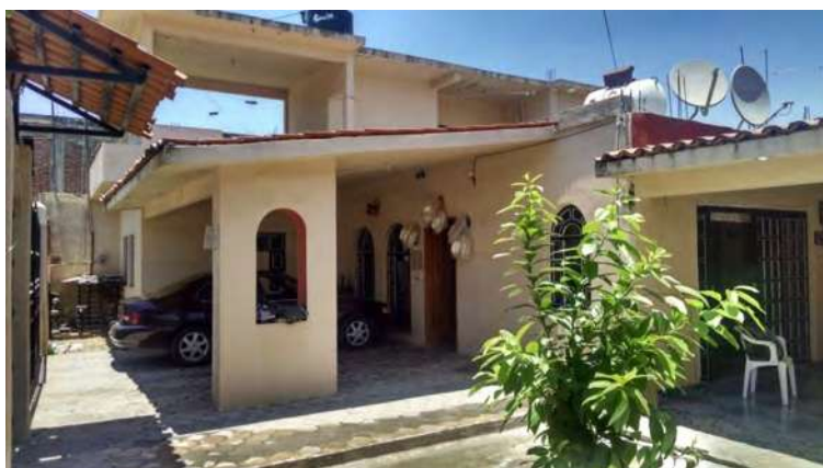
VISTA EXTERIOR HACIA LAS COCHERAS E INGRESO
