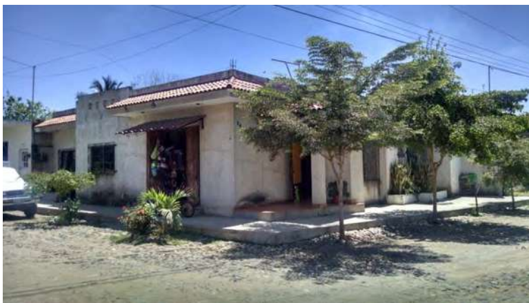
VISTA EXTERIOR DESDE LA ESQUINA
