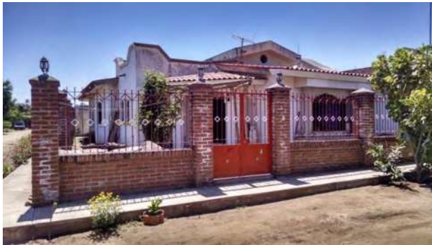
VISTA EXTERIOR DEL INGRESO
