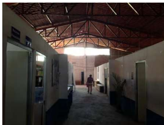
Ilustración 3 edificio interior, foto autor.
