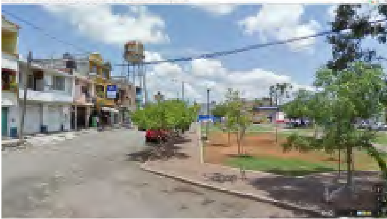
Imagen 46. Tanque elevado para distribución de agua potable.
