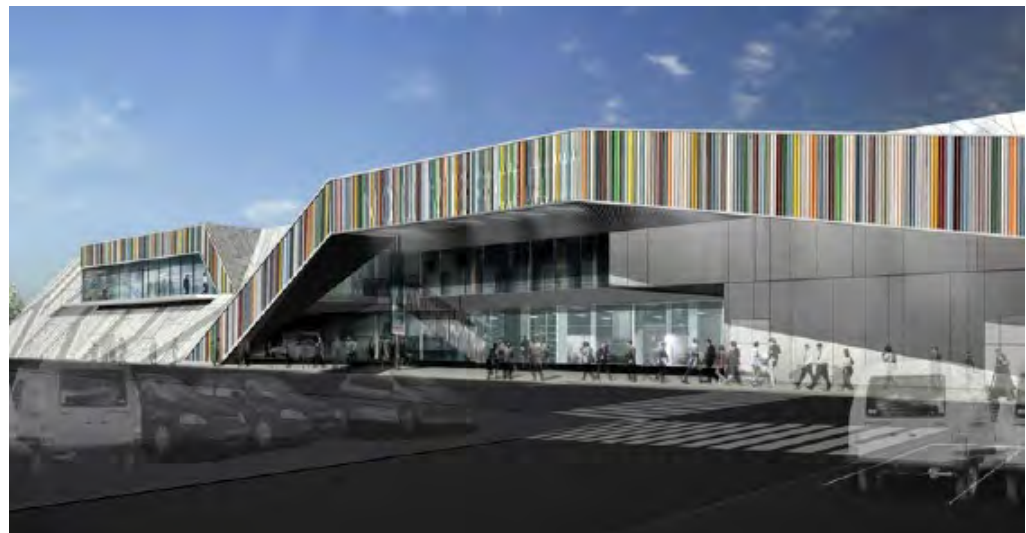
Imagen 66. Acceso a segundo nivel (zona de administración).
