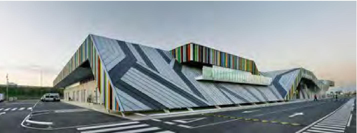
Imagen 65. Panorámica lateral de andenes de carga.
