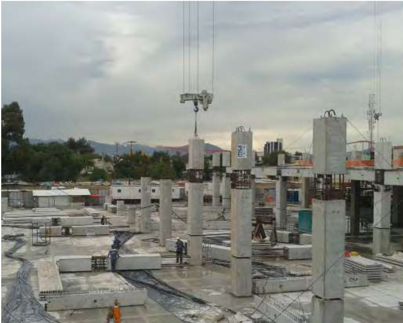
Imagen 41. Proceso constructivo en obra civil.
