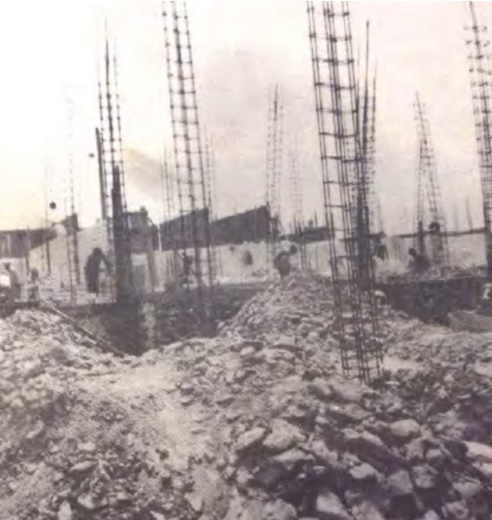
Imagen 21. Construcción de la central de Abastos de Morelia primera etapa.
