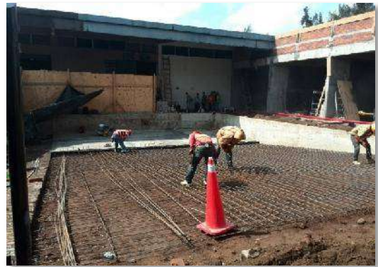
AREA DE EMBARQUES: Armado de varilla para los firmes de concreto.
