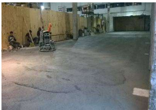
CAMARAS FRIAS: Terminación de firmes de concreto.
