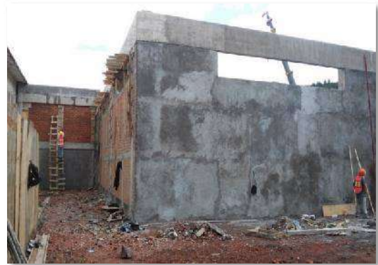
ALMACÉN: Aplanados a base de mortero, apreciándose las cadenas de cerramiento que conforman estos elementos estructurales.
