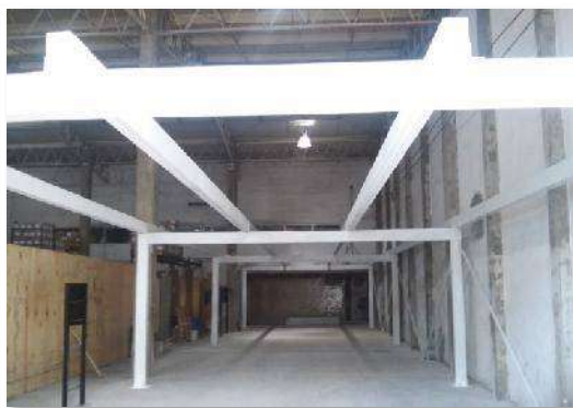
CAMARAS FRIAS: Detalles de los elementos estructurales donde se colocaron las cámaras frías y equipos refrigerantes especiales.
