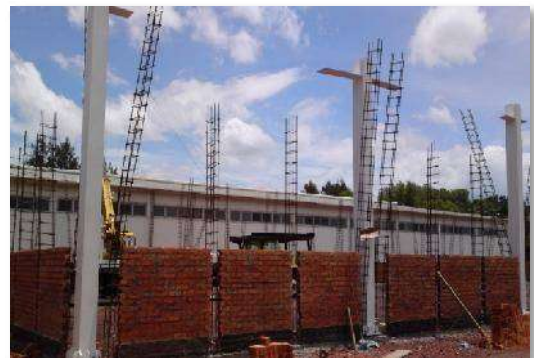
ALMACEN: Colocación de los muros de tabique rojo recocido, así como sus correspondientes estructuras metálicas de soporte, propuestas en el plano estructural de este elemento.
