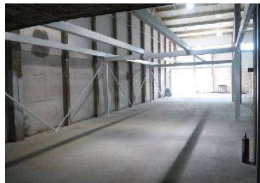
CAMARAS FRIAS: Colocación de estructuras a base de PTR, según planos estructurales.
