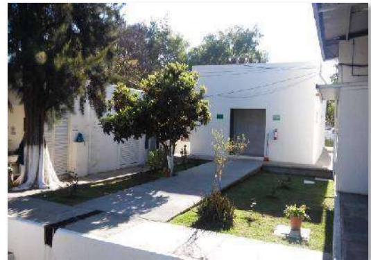
AREA DE BAÑOS Y VESTIDORES: Terminación de esta sección ya debidamente aplicada la pintura vinílica, así como sus áreas verdes, según las especificidades indicadas en los planos que solicitó el departamento de construcción de esta institución.
