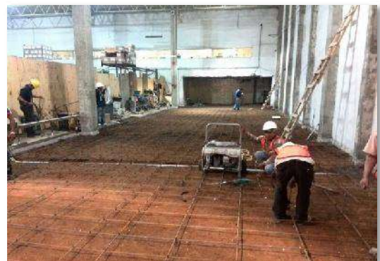
CAMARAS FRIAS: Trazo y nivelación de firmes, para recibir su respectivo armado de varillas, ya con las columnas desplantadas.
