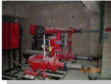
Sistema contra incendios "Tuberías tipo CPVC y Bombas Booster" (Cámara José Antonio Moreno G.)
