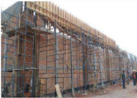
ALMACEN: Colocación de andamios, para continuar con los Aplanados, así como los detalles de la cimbra en la cadena estructural propuesta para esta nave
