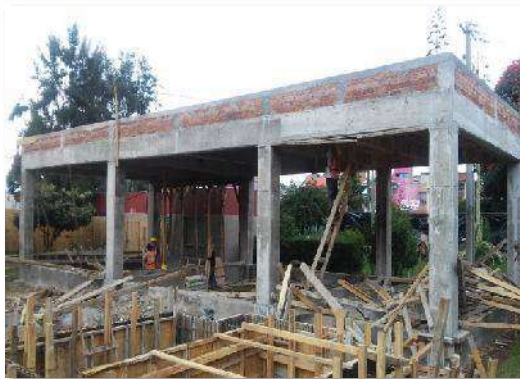
AREA DE BAÑOS Y VESTIDORES: Colado de columnas y cimbrado de las cisternas debidamente habilitadas con acero de refuerzo, según lo avala el plano estructural de este elemento.
