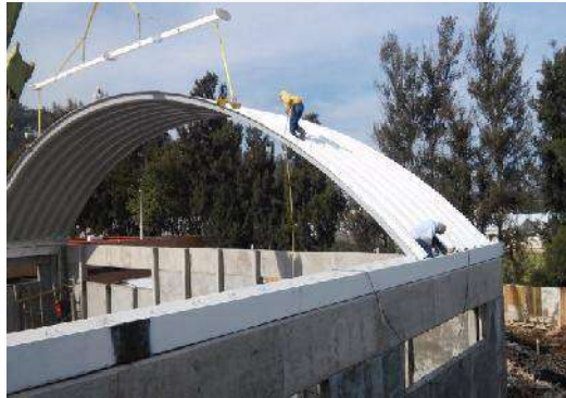
ALMACEN: Colocación del arco techo, así con sus respectivos trabajos de desagües pluviales, calculados tal cual lo solicito el departamento correspondiente de este Instituto
