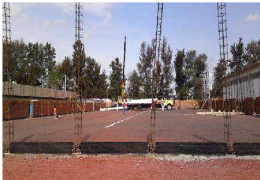
ALAMACEN: Nivelación para los firmes, apreciándose el detalle de las dalas de desplante con su respectivo impermeabilizante, y detalle de los castillos armados en obra.
