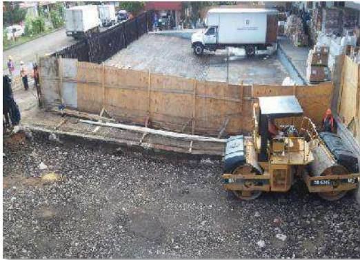
AREA DE EMBARQUES: Trazo y nivelación para recibir el firme.
