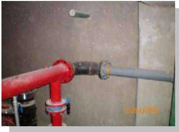
Sistema contra incendios "Tuberías tipo CPVC y Bombas Booster" (Cámara José Antonio Moreno G.)
