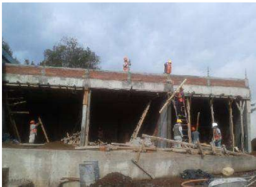
ZONA DE EMBARQUES: Habilitación de la losa de concreto, así como los pretiles consideraos en el diseño de estos elementos.
