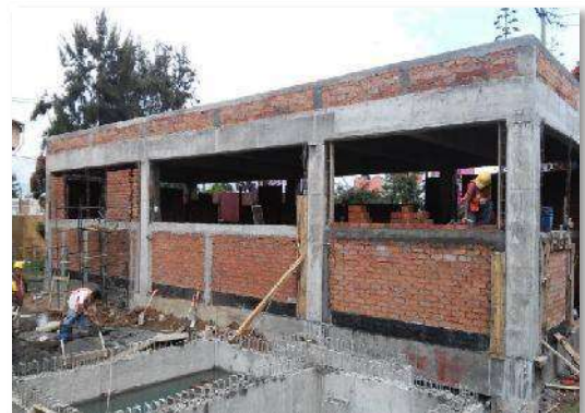
AREA DE BAÑOS Y VESTIDORES: Detalle de los muros de tabique de barro rojo recocido, y la cisterna ya descimbrada.
