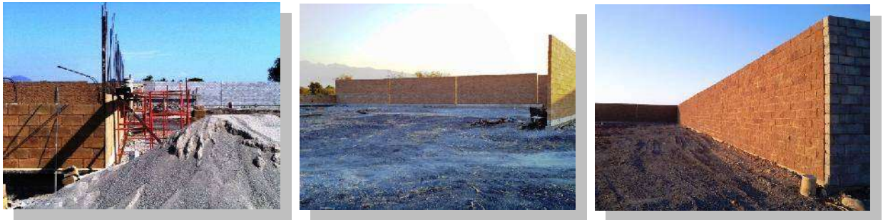
Muro perimetral, para “CITROJUGO” Apatzingán Michoacán (Cámara José Antonio Moreno G.)
