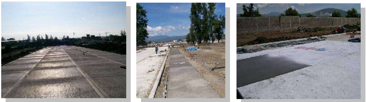
Pavimentación en vialidades a base de concreto hidráulico (Cámara José Antonio Moreno G.)
