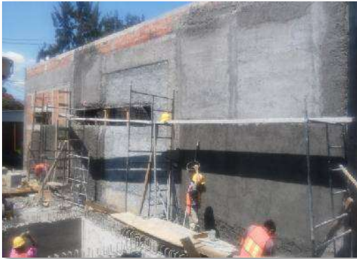
AREA DE BAÑOS Y VESTIDORES: Aplanados a base de morteros según especificaciones en bitácora, con acabado en fina.
