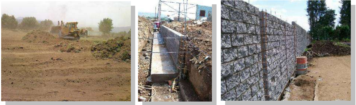
Despalme, excavación, cimentación y muro, (Cámara José Antonio Moreno G.)
