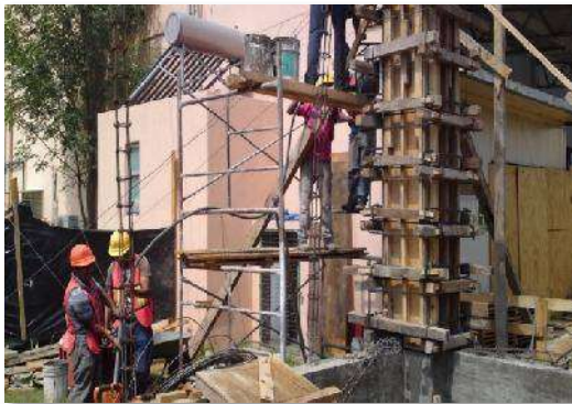
AREA DE BAÑOS Y VESTIDORES: Cimbrado y colado de columnas, refiriendo el detalle de la cimbra utilizada en estos elementos estructurales.
