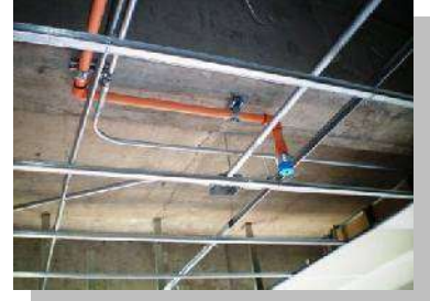
Sistema contra incendios "Tuberías tipo CPVC y Bombas Booster" (Cámara José Antonio Moreno G.)
