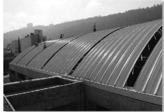
ALMACÉN: Terminación del arco techo.
