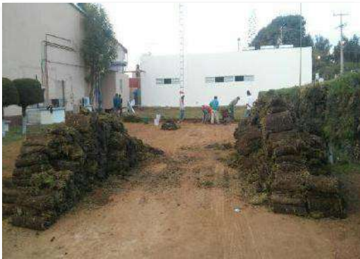
AREA DE BAÑOS Y VESTIDORES: Terminación de la jardinería propuesta para esta sección en particular.
