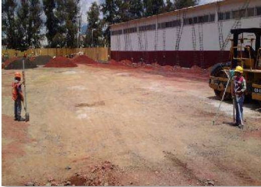
ALMACEN: Trazo y nivelación del terreno donde se proyectó el almacén general.
