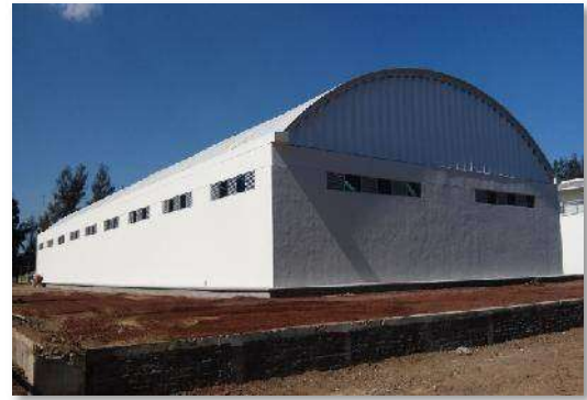
ALMACEN: Terminación de este elemento, ya finalizado su aplanado a base de morteros y aplicación de la pintura vinílica.
