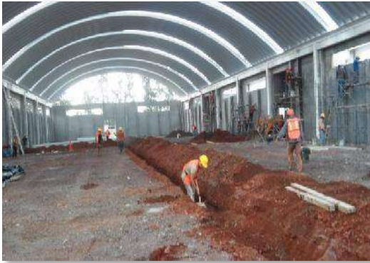
ALMACÉN: Interior del almacén, previo a los firmes, con sus respectivos trabajos de excavación.
