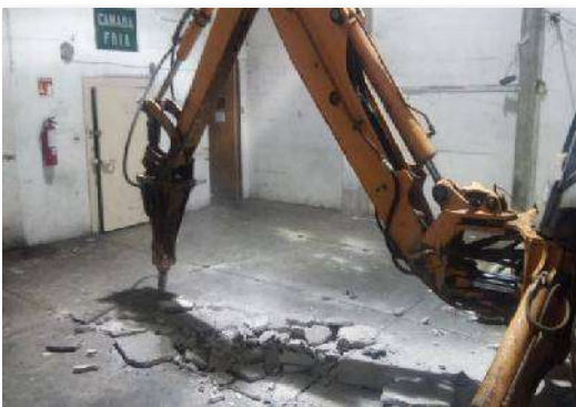
CAMARAS FRIAS: Retiro de firmes de concreto, mediante equipos especiales a base de maquinarias específicas, según lo amerita esta partida de obra.
