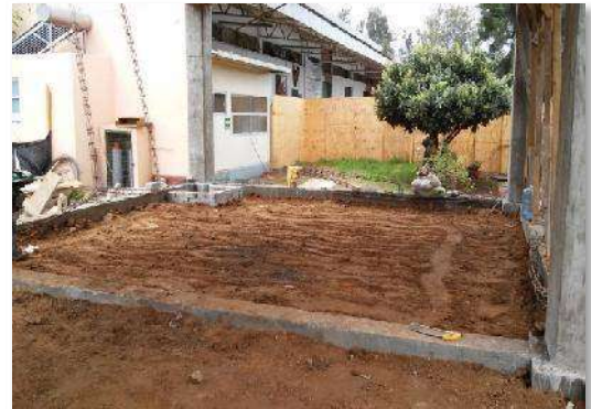
AREA DE BAÑOS Y VESTIDORES: Nivelación para recibir los firmes de concreto en pisos.
